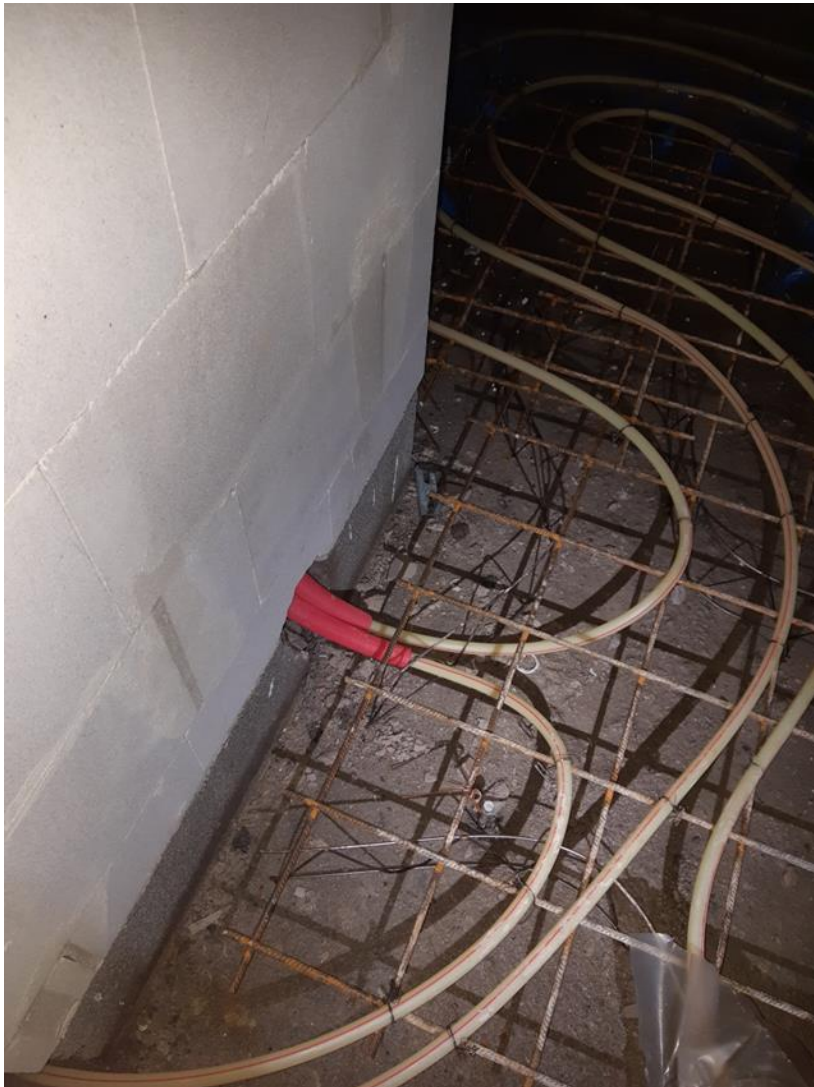
Kuva 9. Lattialämmityksen punainen suojaputki referenssikohteen WC-tilassa. (Tatu Ritarin valokuva-albumi)
