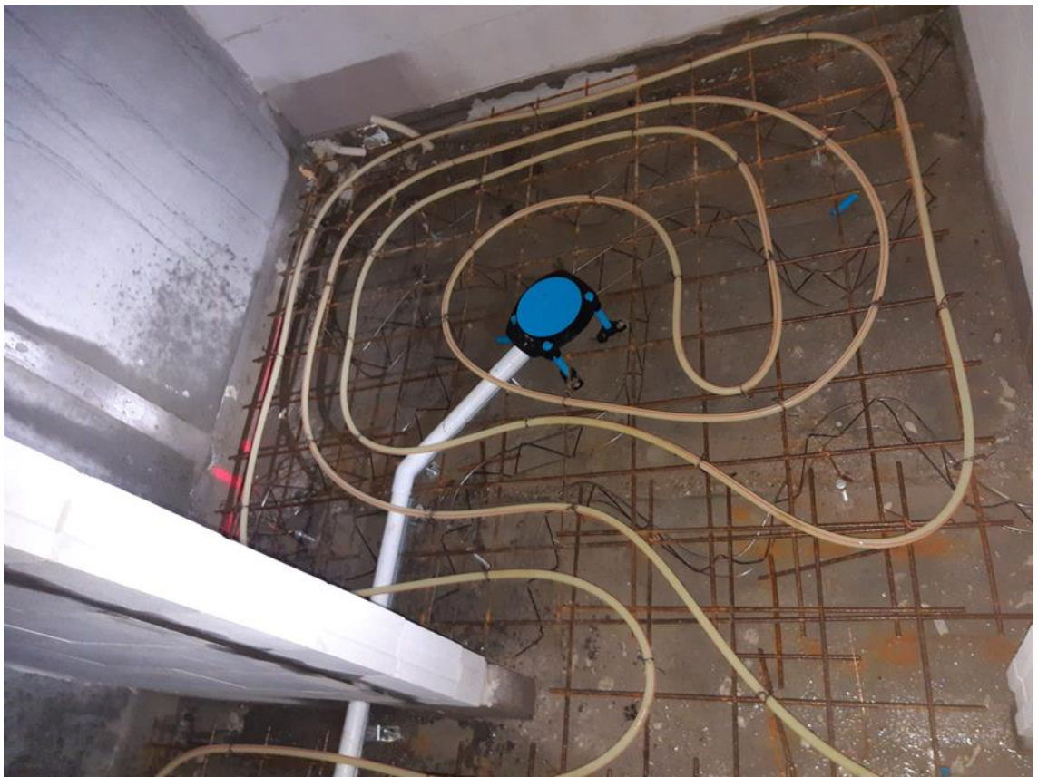
Kuva 11. Esimerkki lattialämmitysverkoston tarkastuskuvasta referenssikohteen WC-tilassa. (Tatu Ritarin valokuva-albumi)
