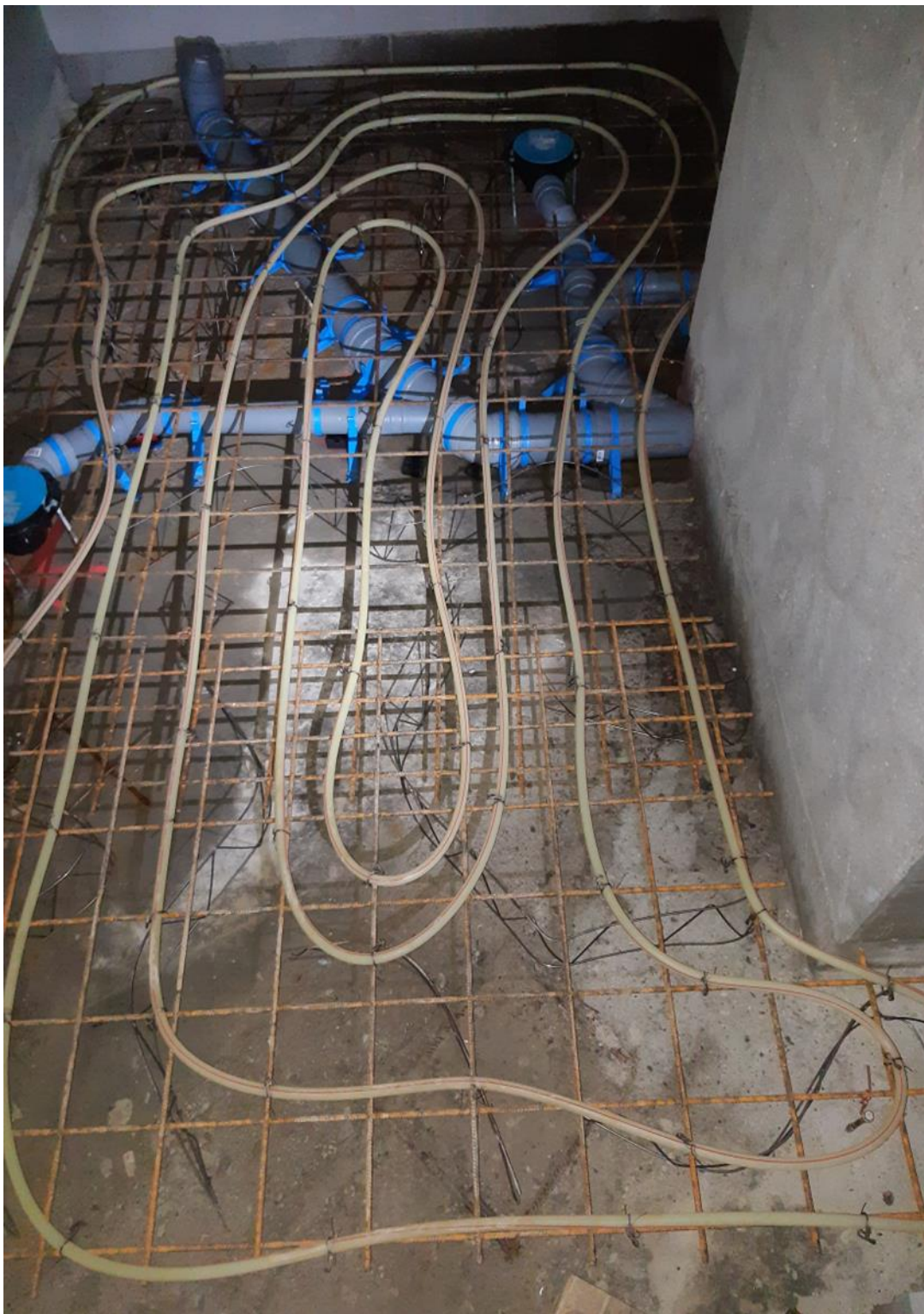
Kuva 7. Lattialämmityspotkiston kiinnikeväli referenssikohteen WC-tilassa. (Tatu Ritarin valokuva-albumi)
