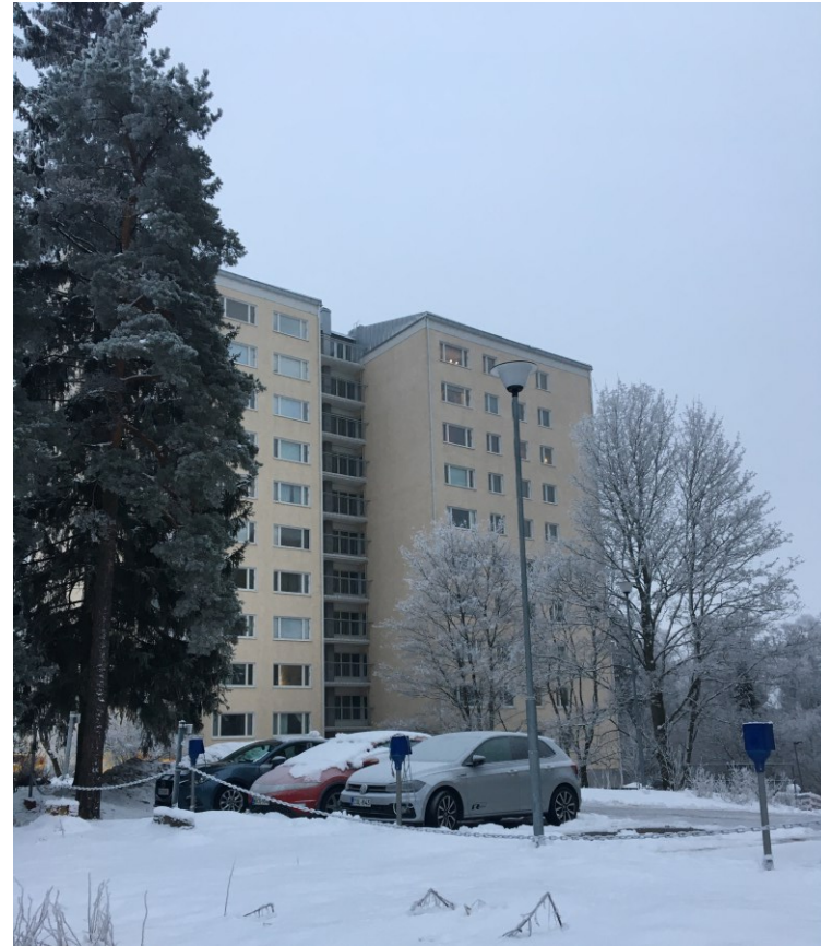
Kuva 10. Suunnittelualueen viereisissä, 50-luvulla rakennetuissa pistetaloissa on julkisivupintana vaalea rappaus.
