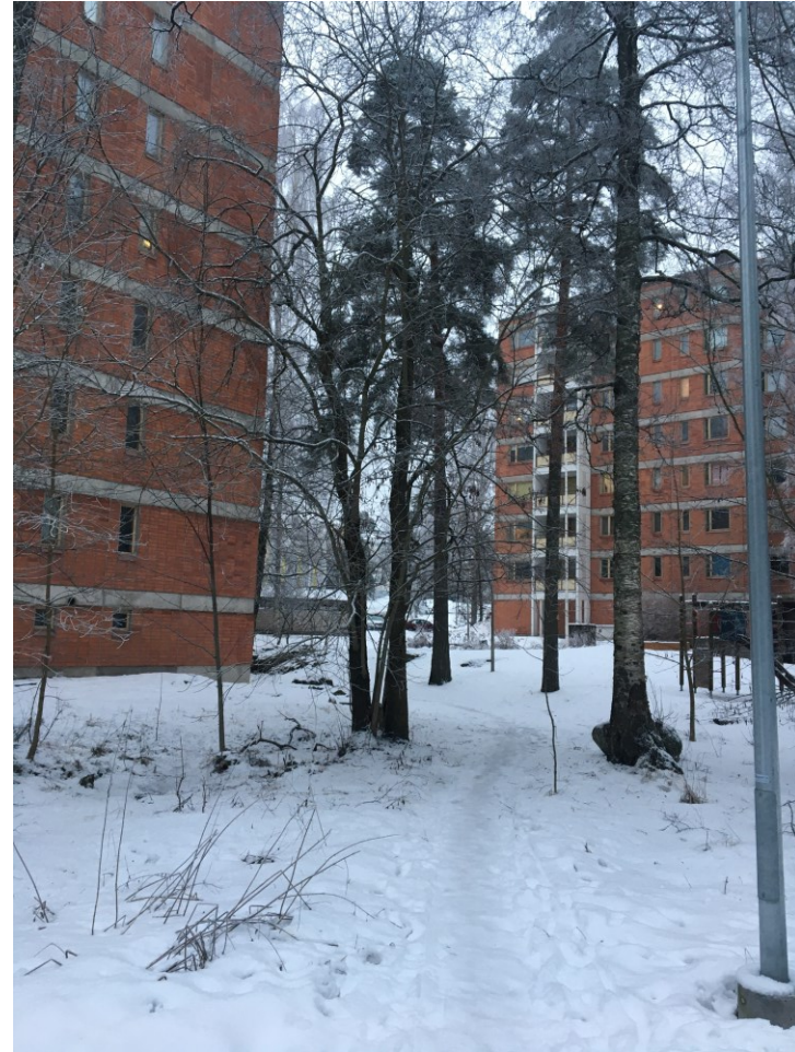
Kuva 8. Alueen pohjoispuolella sijaitsevia seitsenkerroksisia kerrostaloja, joiden julkisivut ovat tiililaattapintaisia elementtejä. Kuva tammikuulta 2023.
