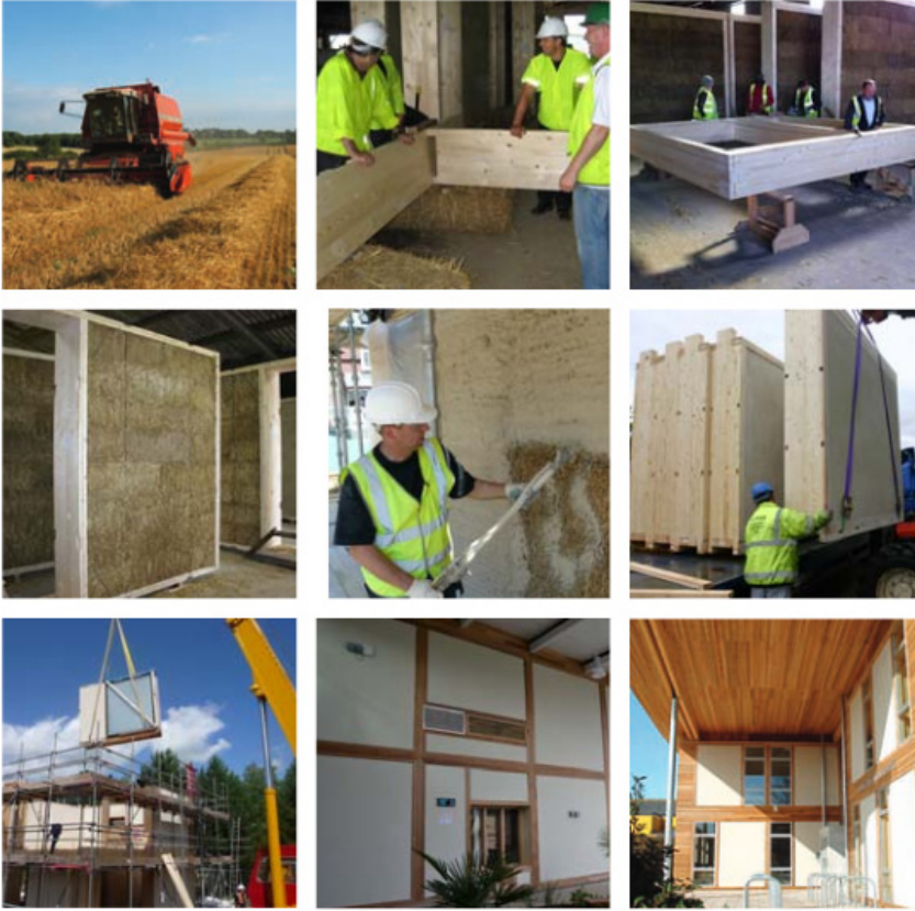
KUVA 28. Olki- ja hampupaaleista valmistettuja seinäelementtejä, joissa kantavat rakenneosat ovat puuta. Valmistaja Modcell© Straw Technology. [89]
