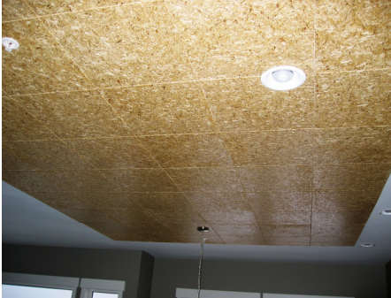
KUVA 31. Tekle Technical Services on kehittänyt biokomposiitteja, jotka soveltuvat käytettäväksi mm. huonekaluissa ja asuntojen sisäpinnoissa [92]
