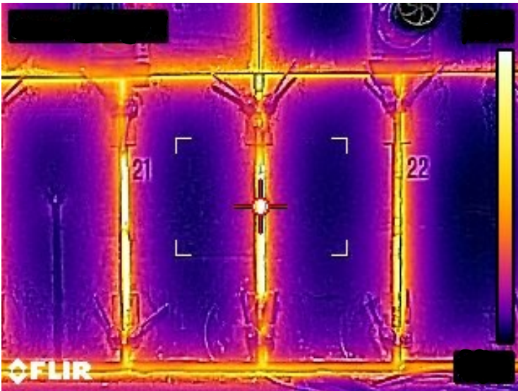
Kuvio 10. Lämpökamerakuva viilunkuivasukoneen 1 ovista
