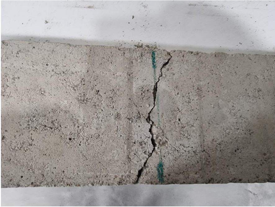
Kuva 9. Säröily ylhäältä.
