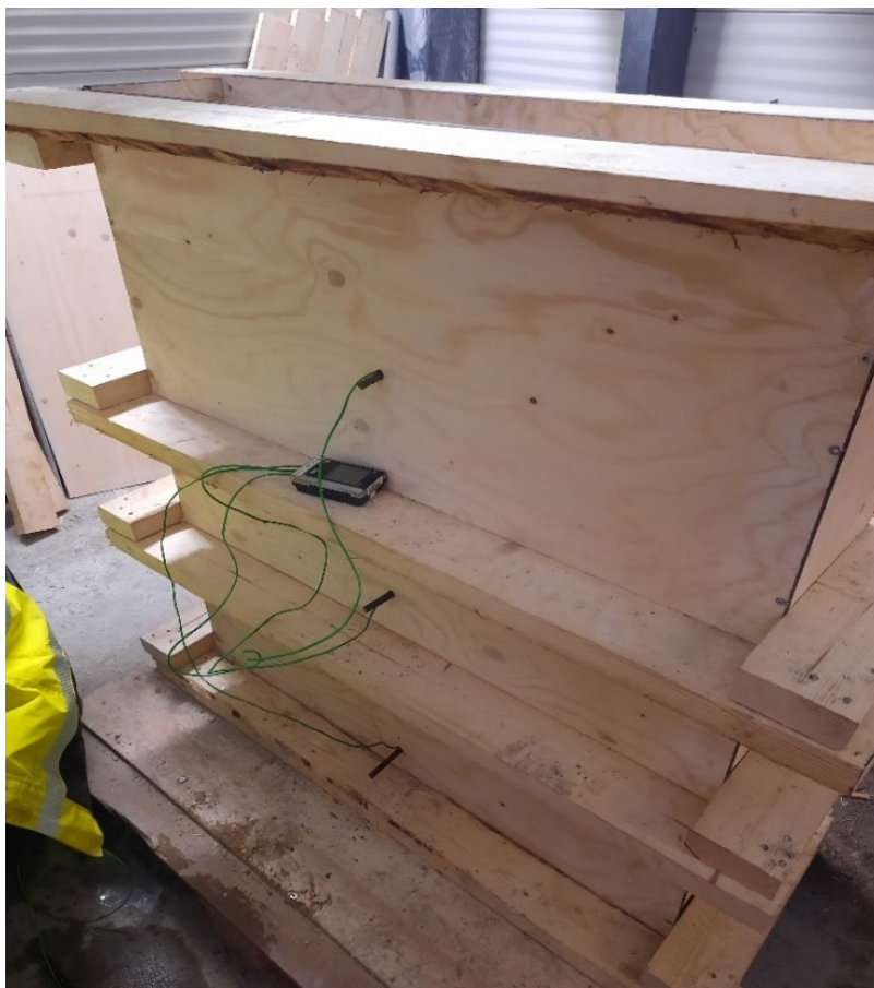
Kuva 11. Sisätiloihin sijoitettava valmis seinämuotti
