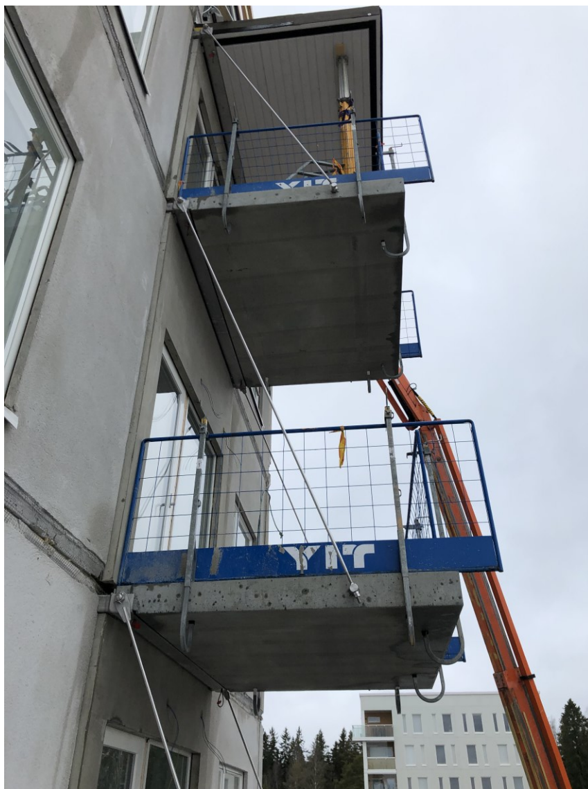
KUVA 5. Paikalleen asennettuja vetotankoparvekelaattoja uudiskohteella Tampereen Niemenrannassa (Salin 2023).
