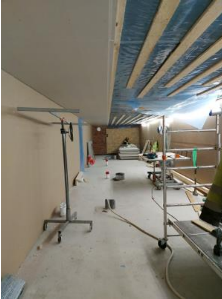
KUVA 17. Kipsilevyn asennusta kattoon
