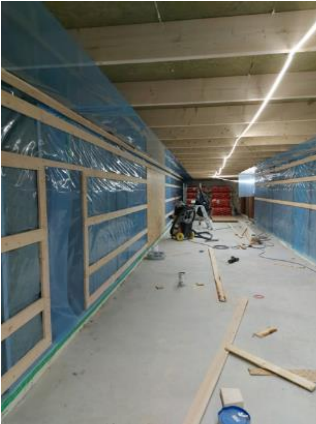
KUVA 16. Konehuoneen höyrynsulun ja rimojen asennusta
