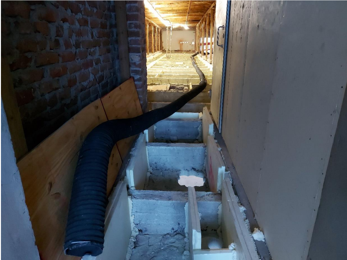
KUVA 11. Vaahtolasimursketäyttöön tarvittiin vain pumppuauto, murske ja letku
