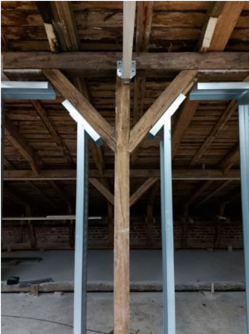
KUVA 14. Puurungon ympärille asennettiin termoranka
