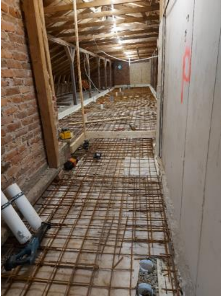
KUVA 13. Lattia raudoituksen jälkeen
