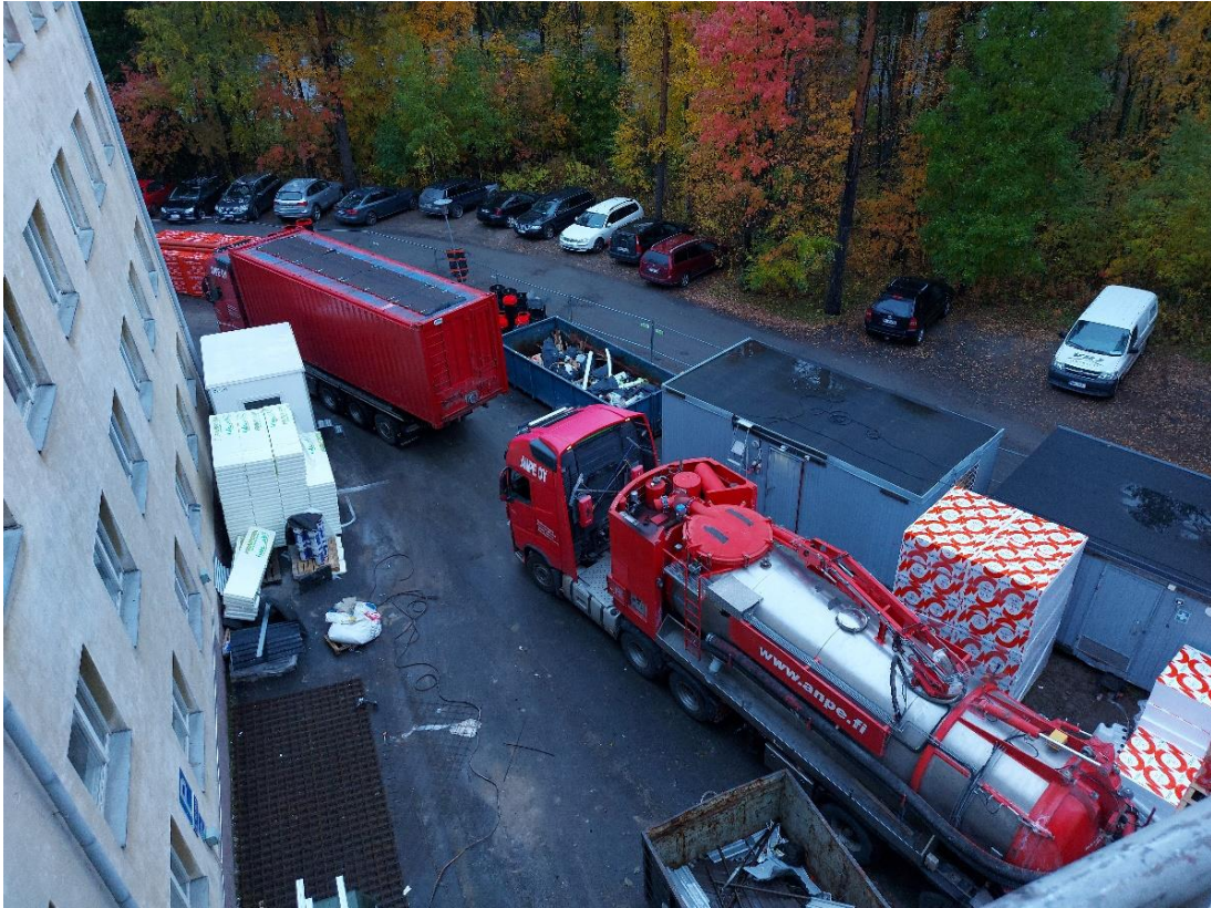
KUVA 10. Vaahtolasimurske tuotiin työmaalle säiliöautolla
