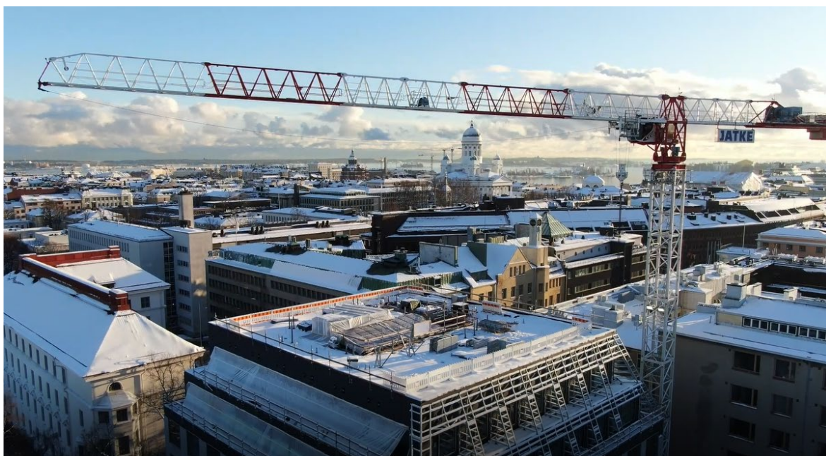
Kuva 31. Nosturi hotellityömaalla, Helsingissä (Jatke 2022)
