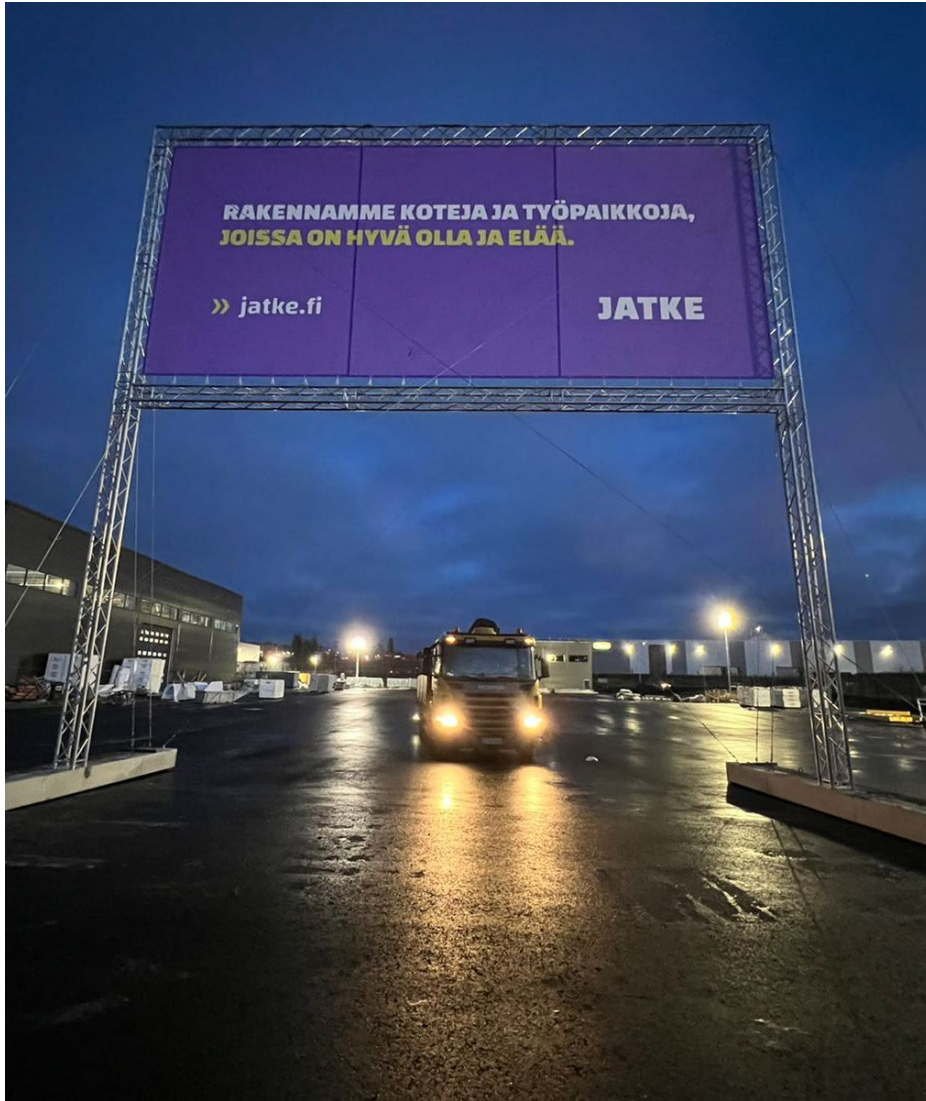
Kuva 32. Valaistu trussiteline Avescon työmaalla Keravalla (Jatke 2022)
