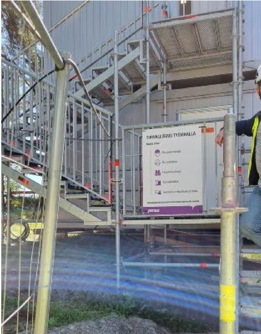
Kuva 5. Vanha opaste Jatkeen rakennustyömaalla Pasilassa (Ahola 2022)
