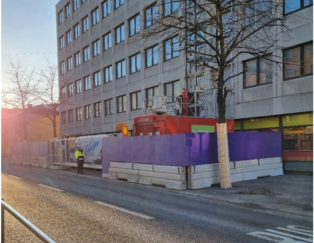
Kuva 7. Mannerheimintien rakennustyömaa (Ahola 2023)
