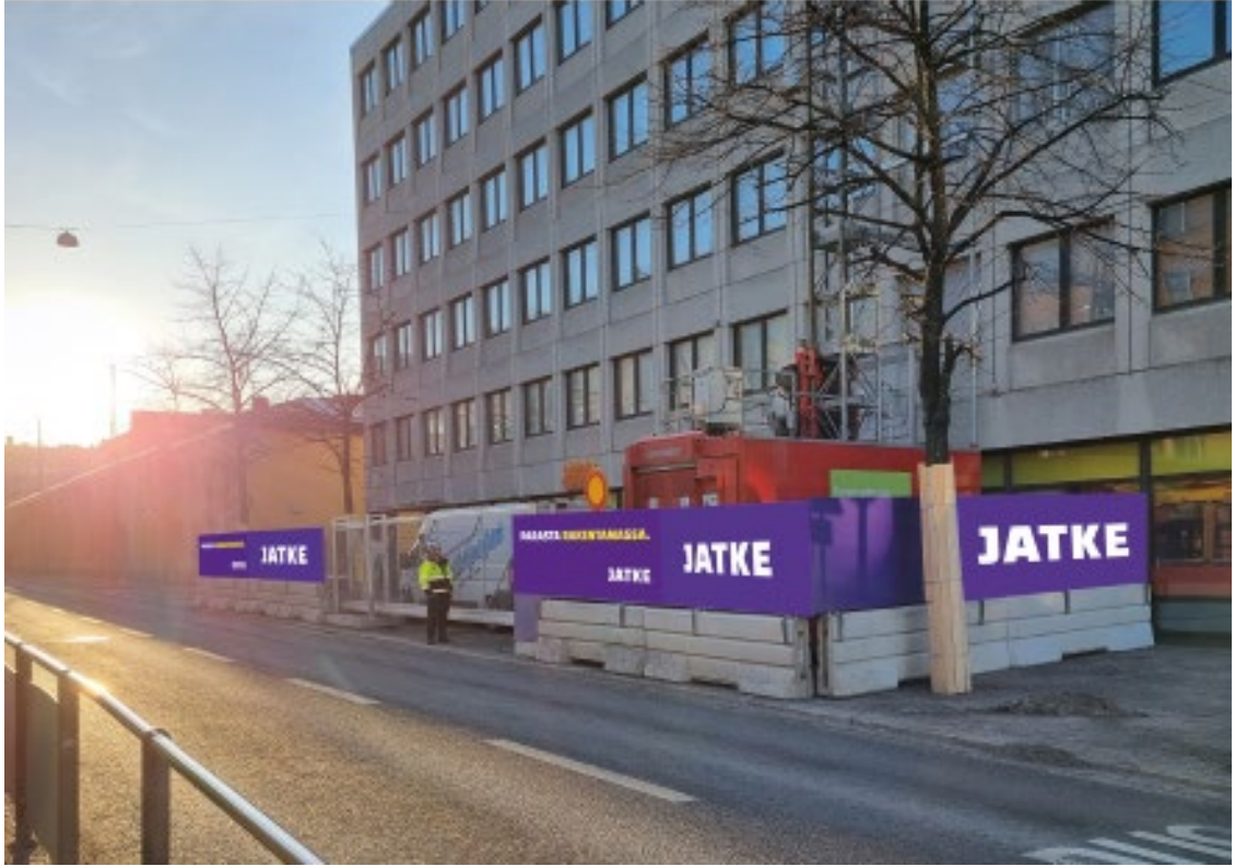
Kuva 30. Havainnekuva Mannerheimintien rakennustyömaanäkyvyydestä (Ahola 2023)
