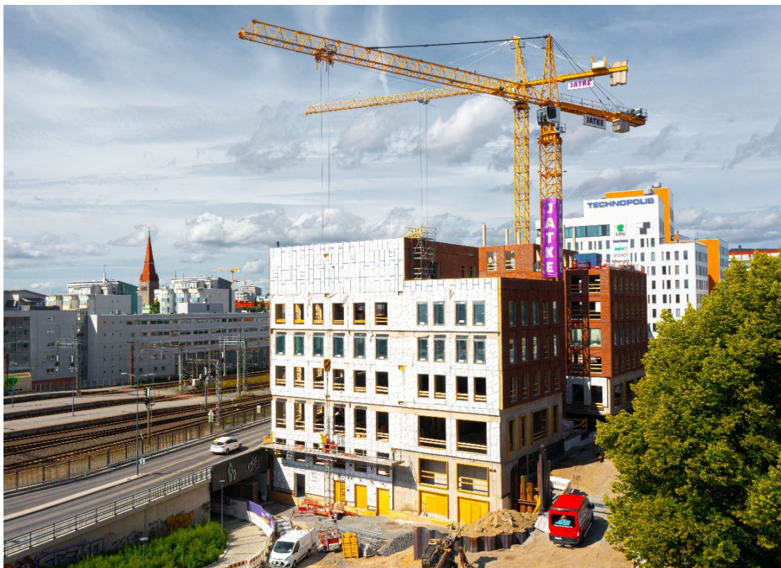
Kuva 33. Nosturimainoksia GO21:n työmaalla, Tampereella (Jatke 2022)
