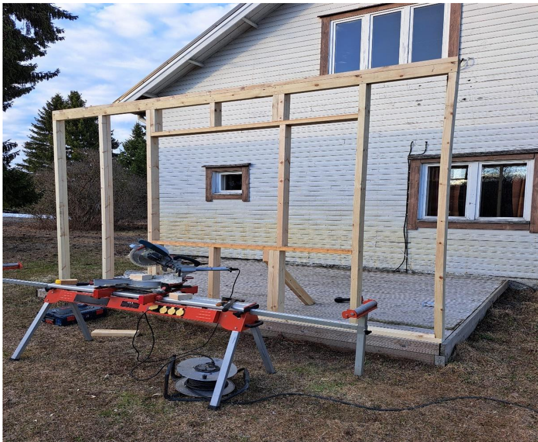
Kuva 19. Runko pystytettynä yhden miehen voimalla
