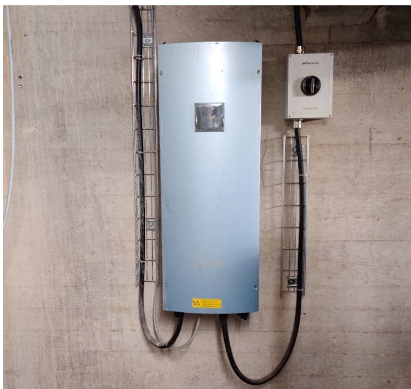
Kuva 7. Hakkurin moottorin taajuusmuuttaja (Rahkjärvi, 2020e).
