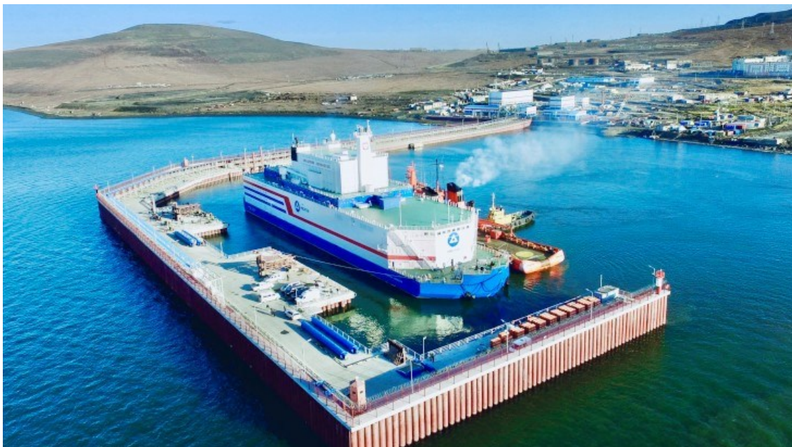
Kuva 6. Kelluva ydinvoimalaitos Akademik Lomonosov. Laitoksen liikuttelussa satama-altaassa käytetään apuna proomuja. [30.]
