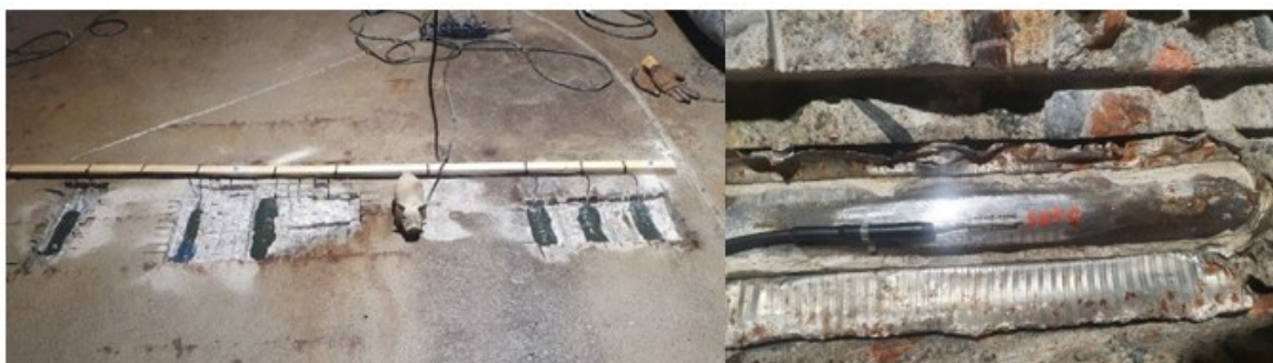
KUVA 32. Hitsatut anturit, jotka kiinnitetty paljastettuihin jänteisiin, KCW-5-120-G10-11G3M3S. (Kalix Bridge Project 2022, 28.)
