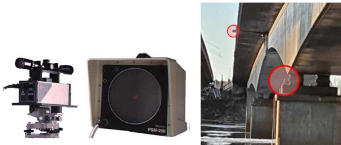
KUVA 31. Siirtymämittari D1 (Lähetin ja vastaanotin) sekä laitteiden sijainti sillalla. (Kalix Bridge Project 2022, 26–27)
