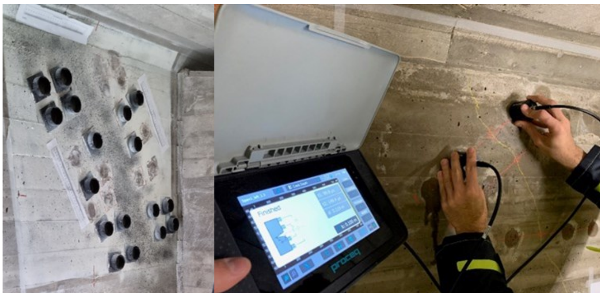
KUVA 14. Halkeaman kiertoajan mittaaminen ultraäänen avulla (Kalix Bridge Project 2022, 93)
