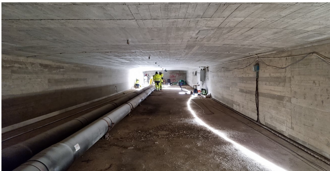
KUVA 6. Näkymä Kalixin sillan jännevälistä viisi. Silta muodostui yhdestä kotelopalkista. (Roslöf 2022)
