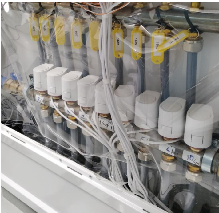
KUVA 4. Lattialämmitysjakotukin merkinnät.
