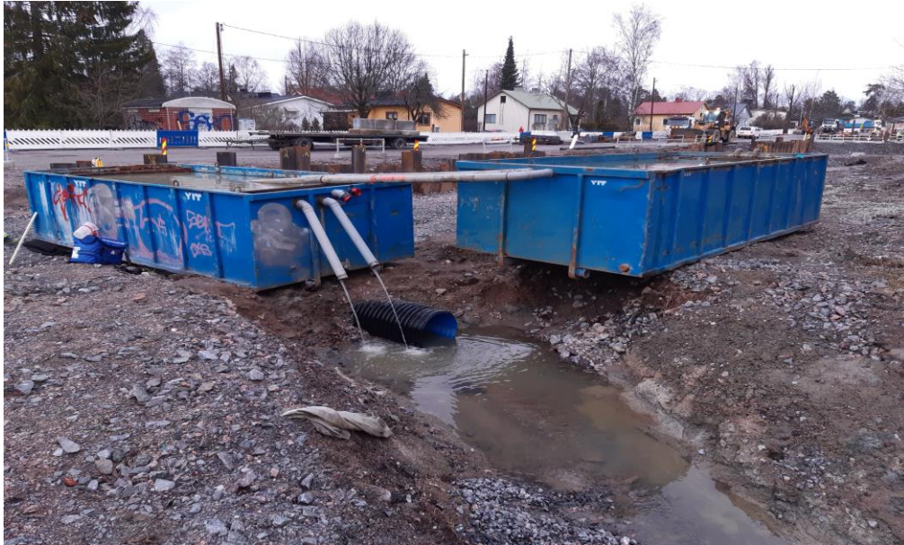
Kuva 11. Pirkkolantien pumppaus- ja laskeutusjärjestelyt 16.1.2020.
