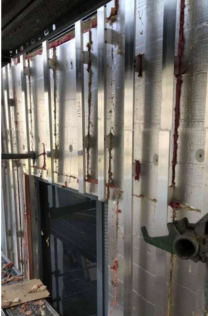
Kuva 63. Hilti MFT-T profiili asennettuna (Järvinen, 2021)
