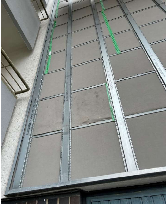
Kuva 49. Tuulensuojateippi ja tuulettuva hattuersi (Collander, 2022)
