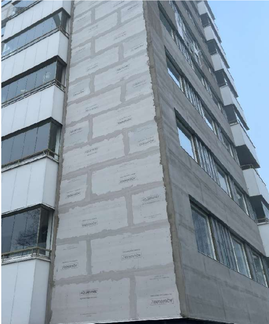
Kuva 19. Knauf kulmaverkko asennettu (Collander, 2022)
