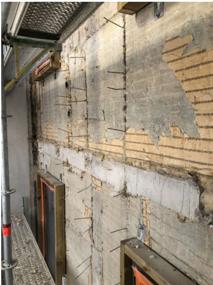
Kuva 58. Puhdistettu sisäkuoren pinta (Järvinen, 2022)
