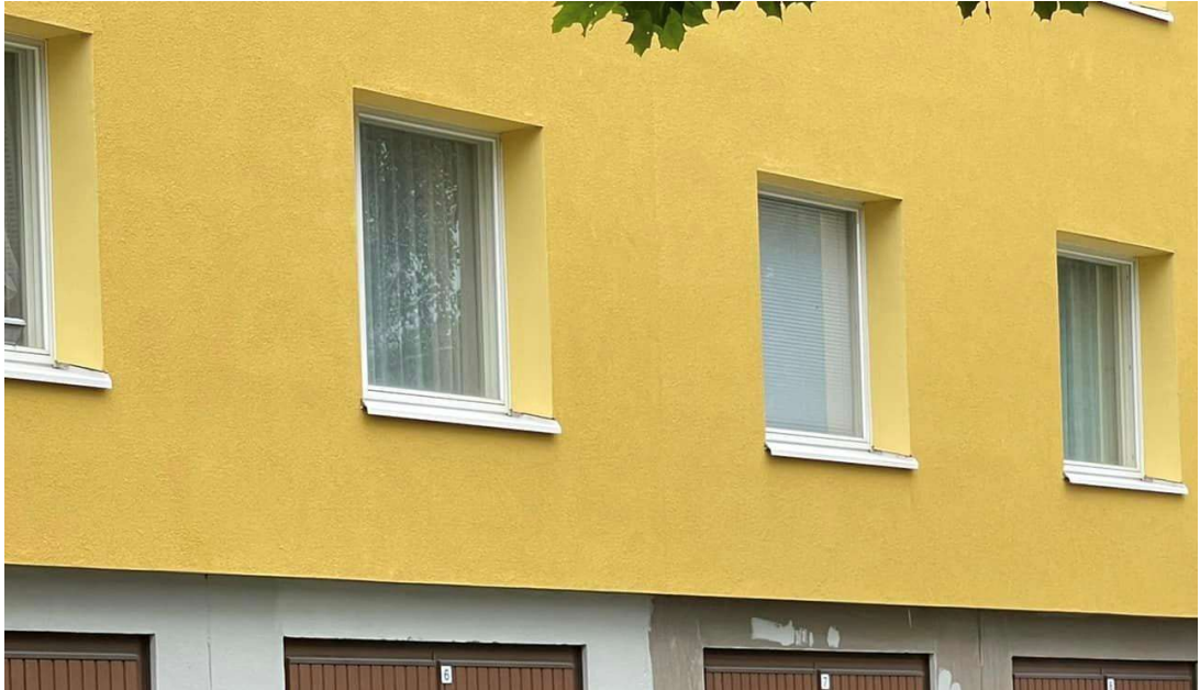
Kuva 45. Ikkuna-aukot syventyneet seinäpaksuuden kasvaessa (Järvinen, 2022)
