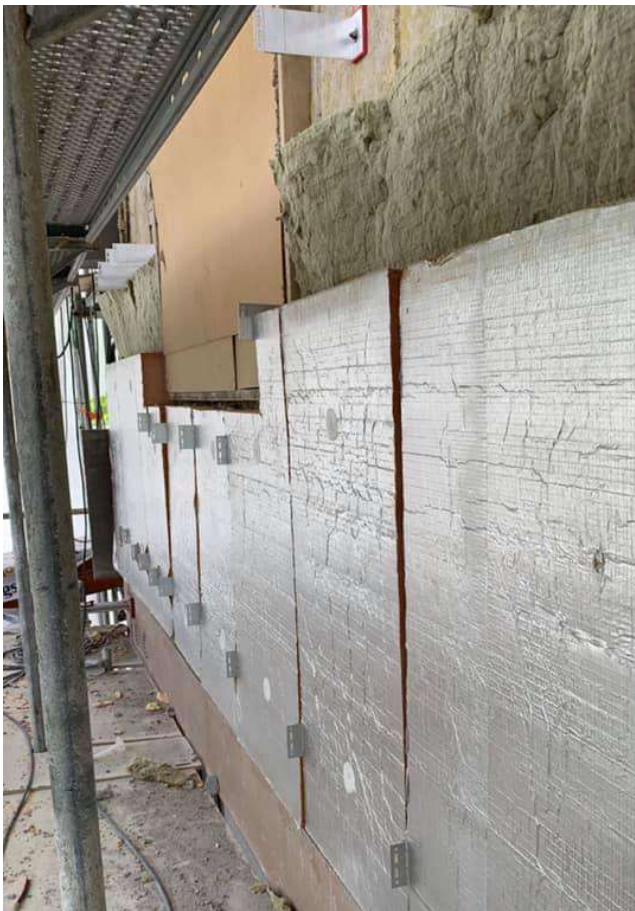
Kuva 62. Tuulensuojavilla pehmeän villan päälle (Järvinen, 2021)
