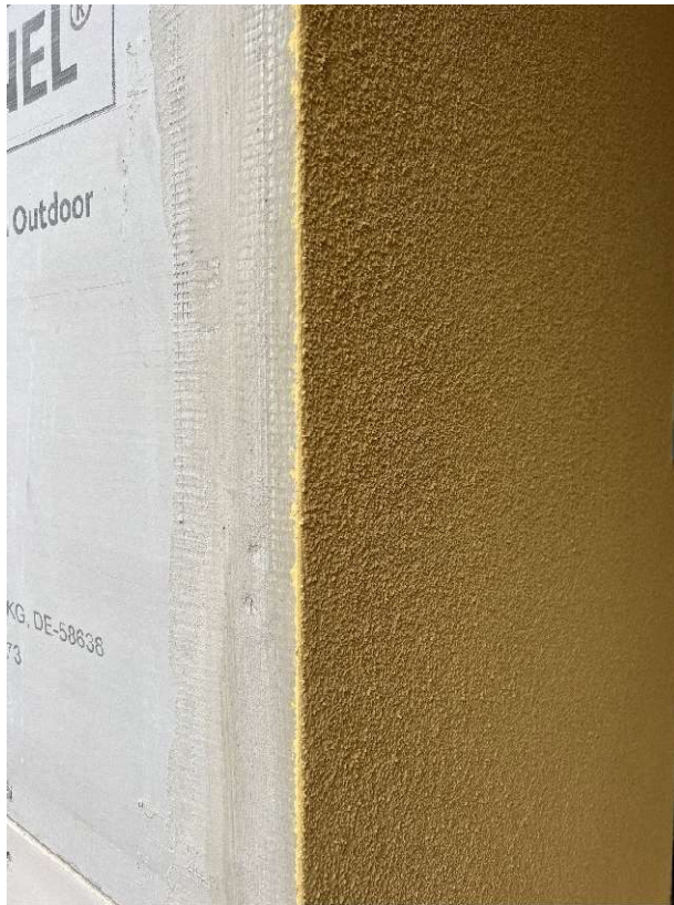
Kuva 24. Valmis levyrappauspinta (Collander, 2022)
