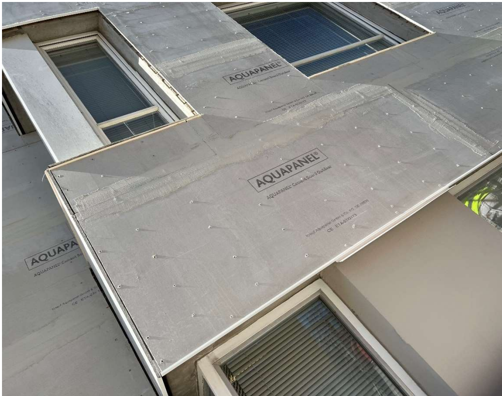
Kuva 14. Aquapanel Outdoor -levyt kiinnitetty Aquapanel Maxi -ruuveilla (Collander, 2022)
