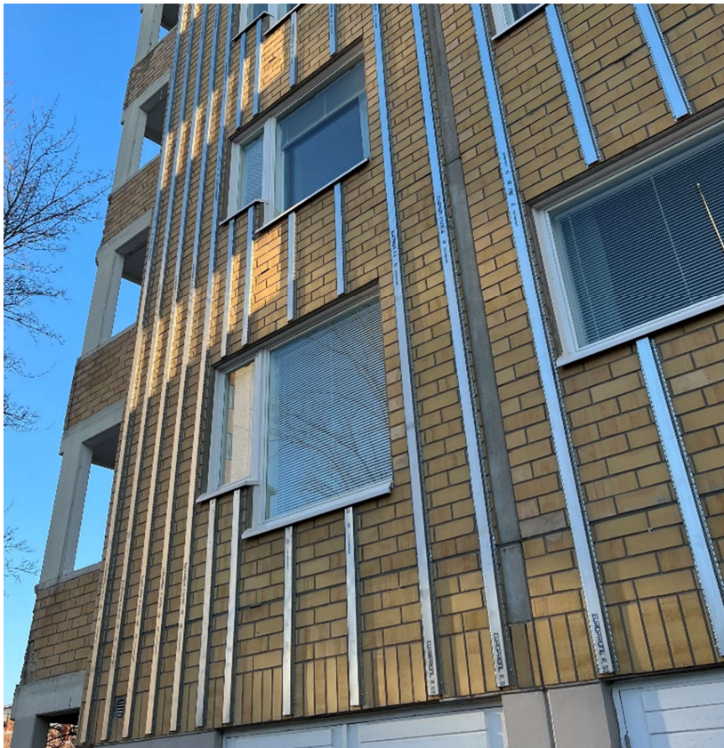
Kuva 8. Tuulettuva hattuorsi asennettuna (Collander, 2022)
