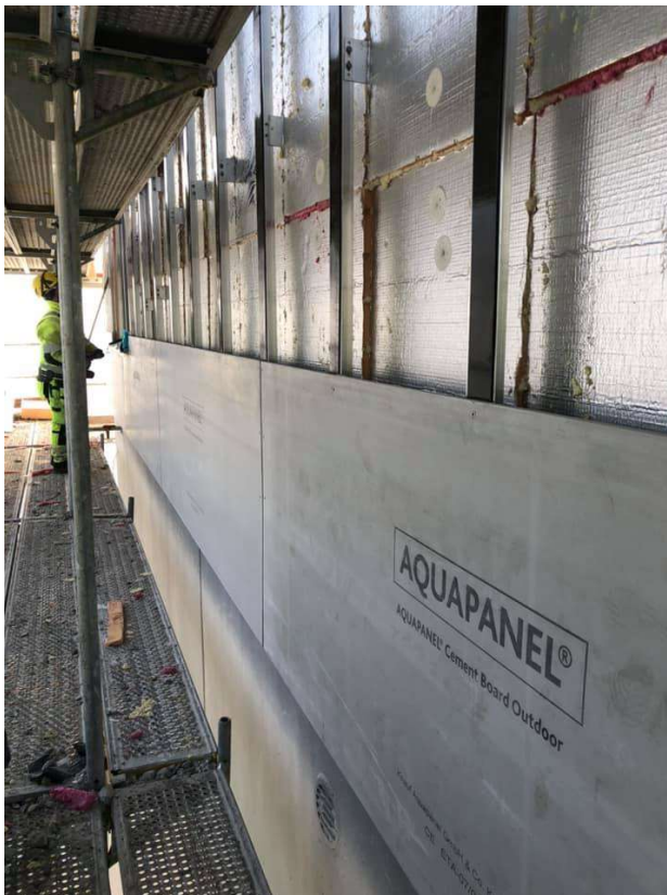
Kuva 65. Knauf Aquapanel Outdoor -levyn kiinnitys Hiltin MFT-T profiiliin (Järvinen, 2021)
