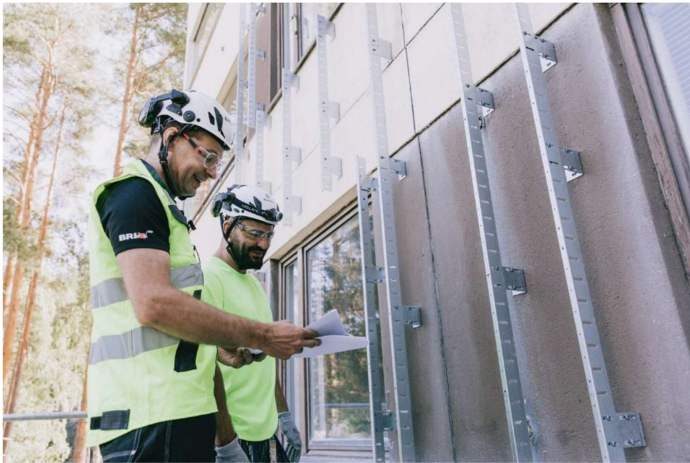
Kuva 53. Eristyskiskon asennus (Stofix Suomi Oy, n.d., s. 21)
