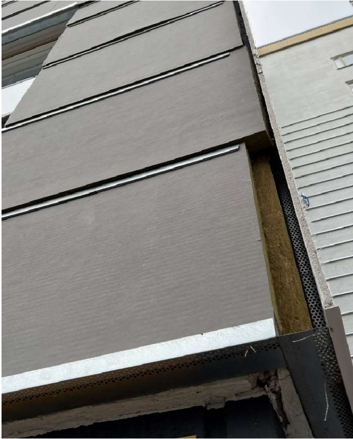
Kuva 48. Tuulensuojavilla asennettu (Collander, 2022)
