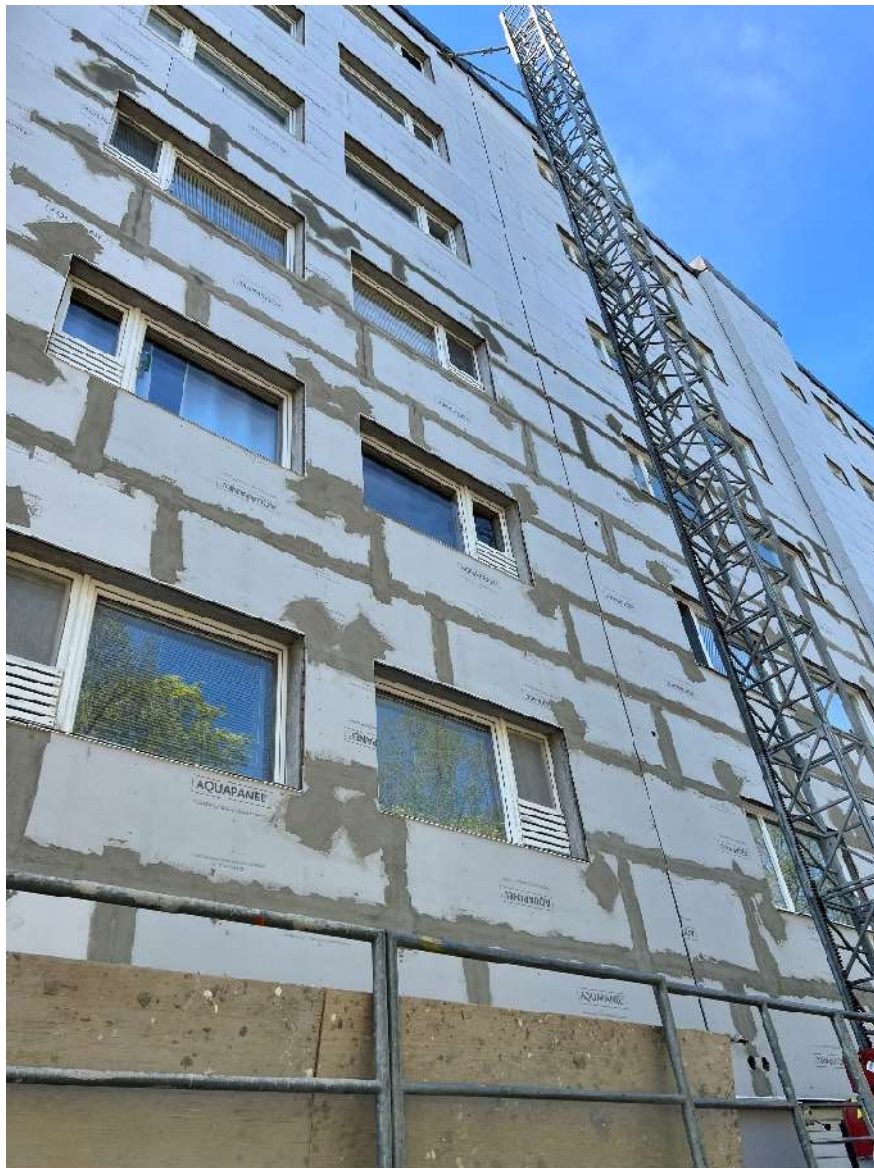
Kuva 18. Knauf Aquapanel saumanauha ja -tasoite asennettu (Collander, 2022)
