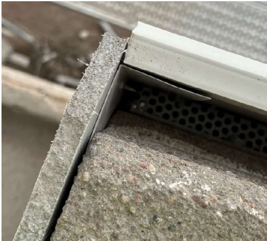
Kuva 15. Kulmaprofiili asennettuna (Collander, 2022)
