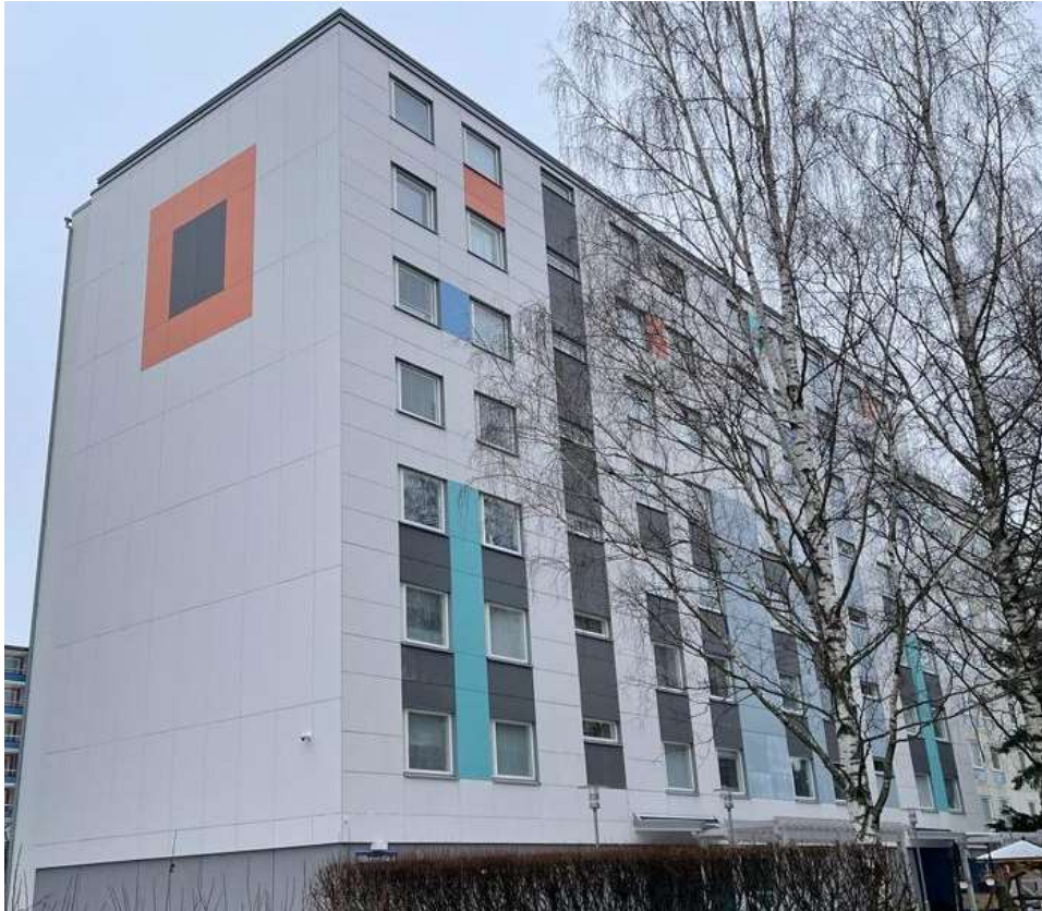
Kuva 43. Valmis kuitusementtilevyjulkisivu (Järvinen, 2023)
