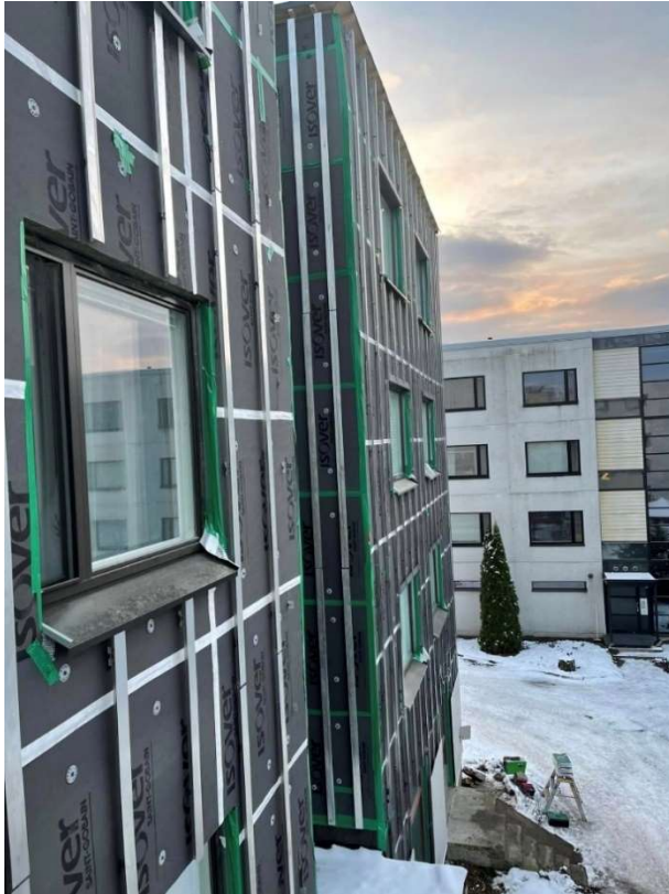
Kuva 64. Hilti MFT-T profiili kiinnitettynä (Järvinen, 2022)
