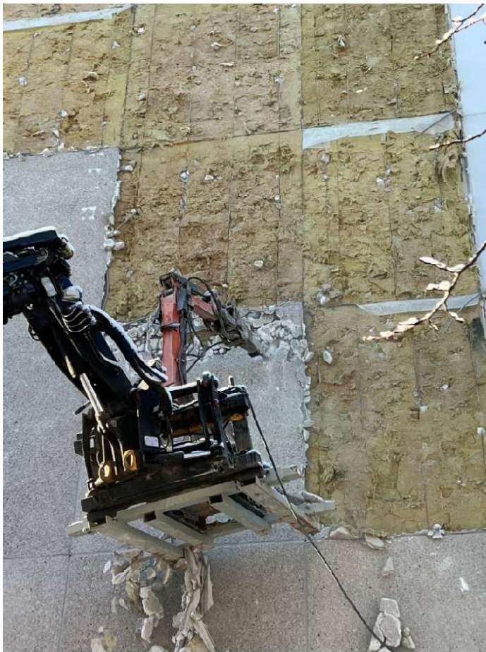
Kuva 57. Robottihiikkaus (Collander, 2023)
