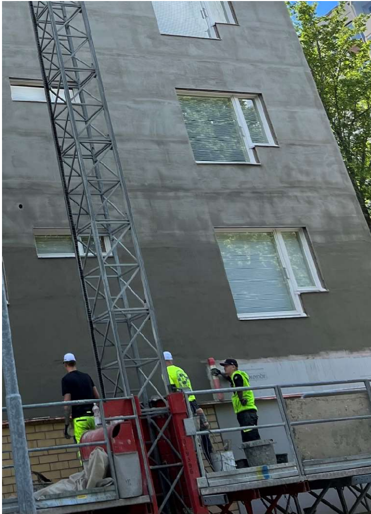
Kuva 20. Lasikuituverkon asennus kuitulaastin avulla (Collander, 2022)
