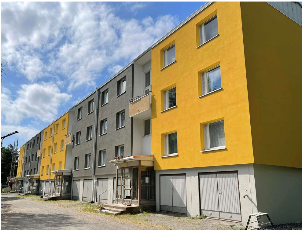
Kuva 25. Valmis levyrappausjulkisivu (Järvinen, 2022)
