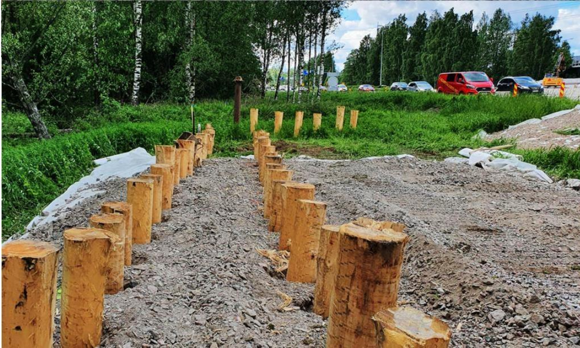
KUVA 8. Asennettuja puupaaluja (Kreate Oy)
