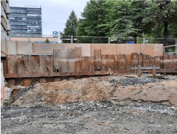
KUVA 1. Teräsponttiseinä (Kreate Oy)
