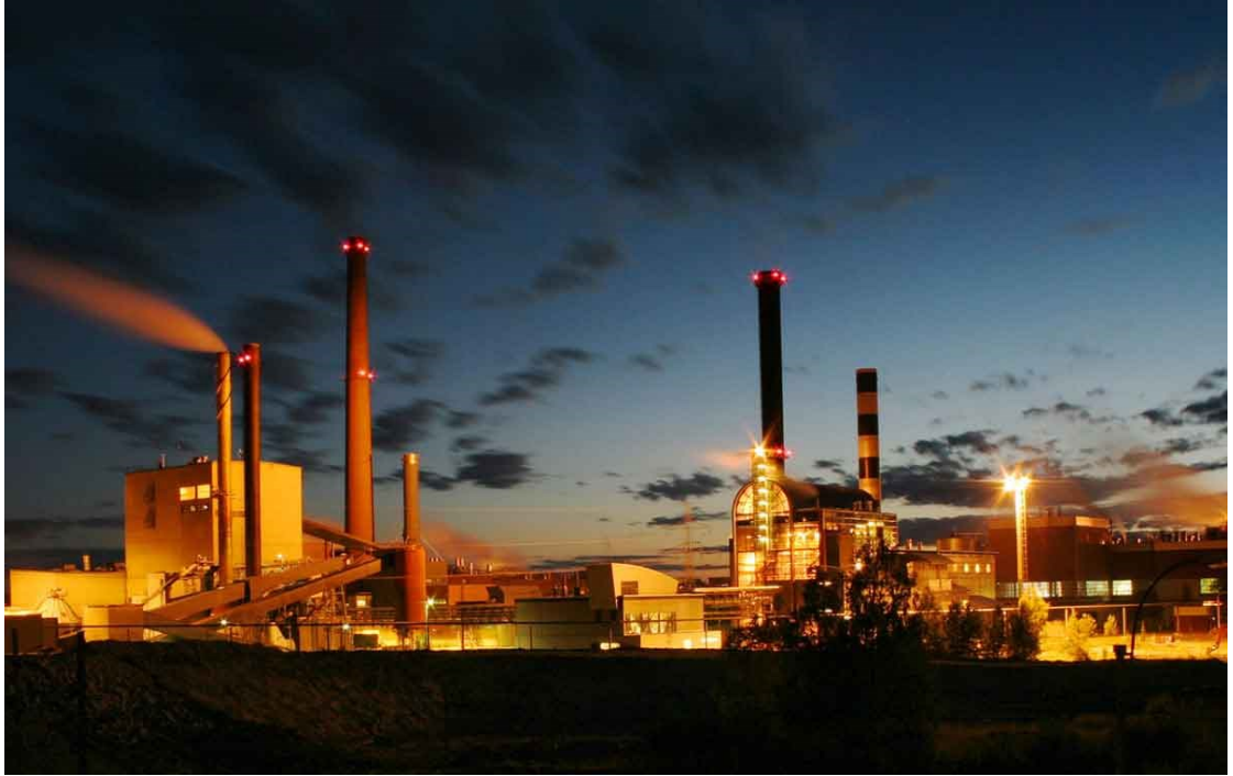
Kuva 1. Stora Enso Anjalankosken tehtaiden voimalaitos (Stora Enso 2023)
