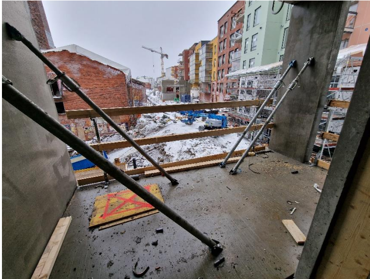
KUVA 7. Parvekelaatan putoamissuojauksena toimii esimerkiksi puiset kaiteet.
