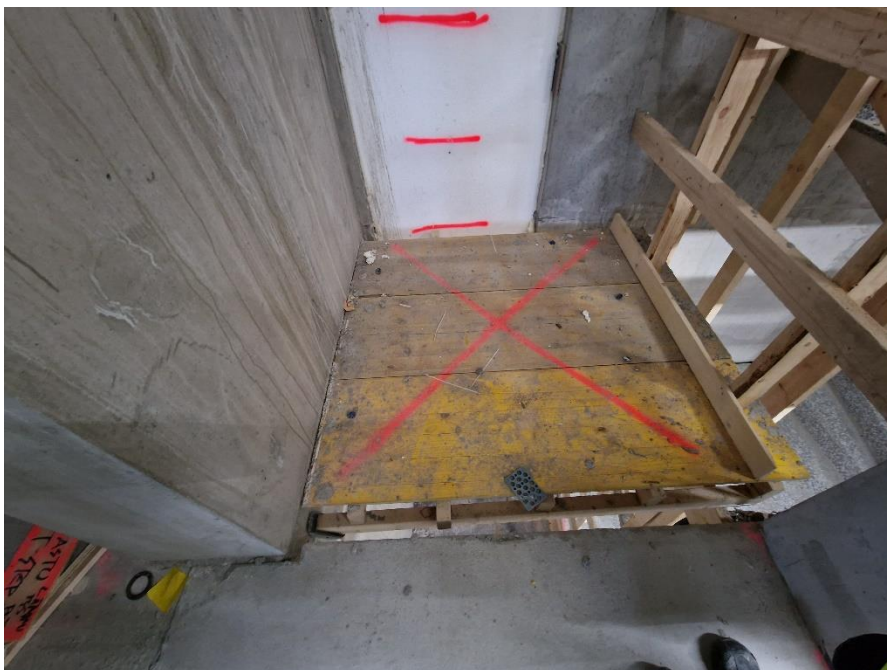
KUVA 4. Aukkosuojauksen merkintä ja esimerkki kaiteesta.
