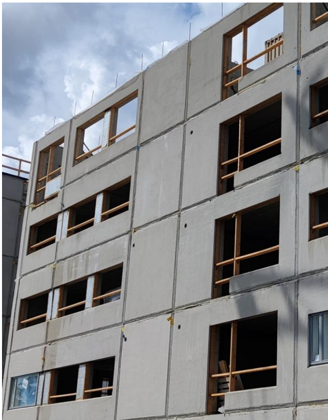
KUVA 5. Elementtitehtaalla asennetut kaiteet.
