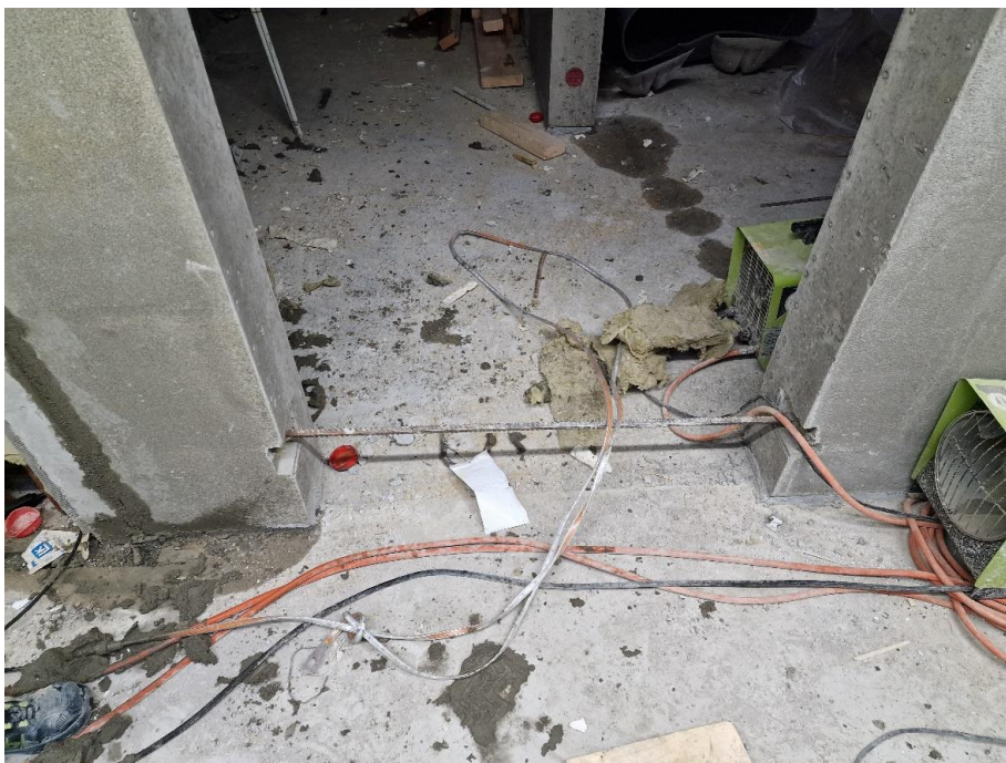
KUVA 6. Oviaukossa harjateräs lisää elementin jäykkyyttä.
