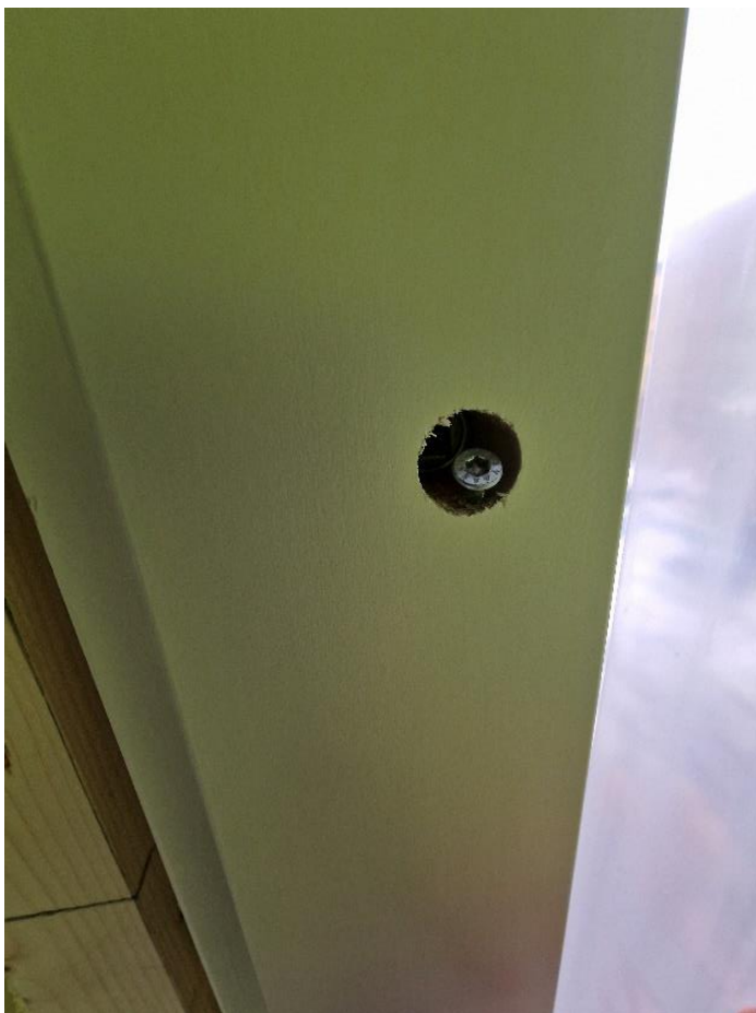
KUVA 2. Parvekeoven putoamissuojaus.
