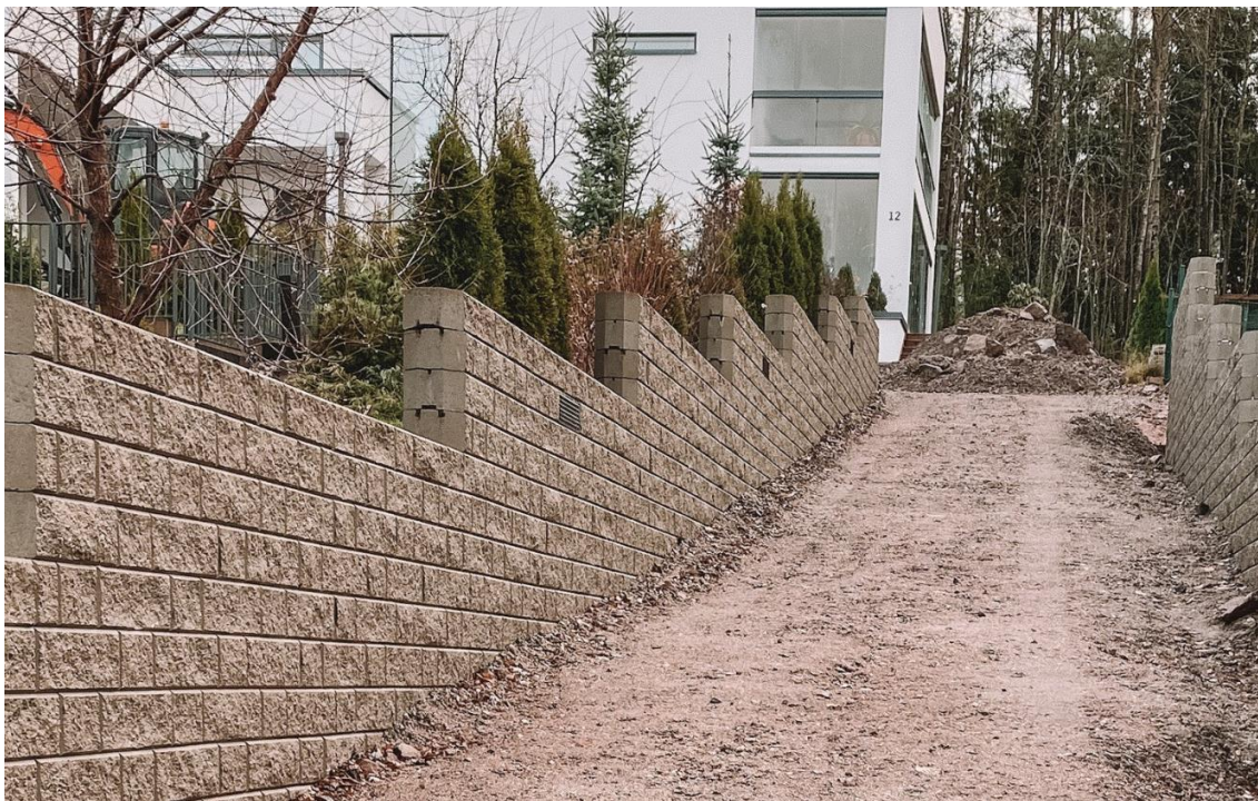
Kuva 3. Ladottava tukimuri jakamassa korkoeroja
