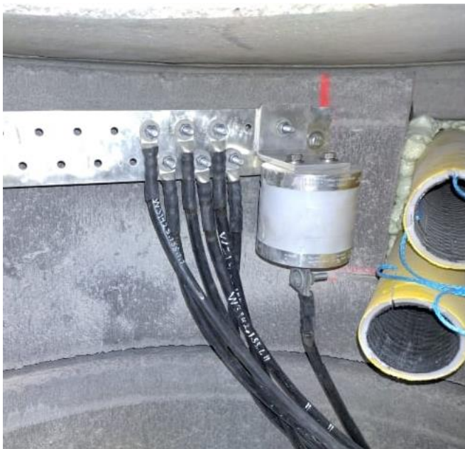
Kuva 5. VLD-F-laitteen asennus kaapelikaivossa. (Lähde: Kruunusillat allianssi katselmuspöytäkirja, mallikatselmus VLD-F-laitteen asennus kaapelikaivossa. luettu 28.3.2023)
