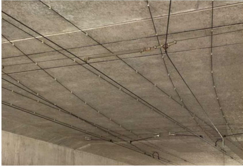
Kuva 20. Virroitinalueen maadoitusjohtimet. (Lähde Maadoitus- ja sähköturvallisuusohje. 2021. Raide-Jokeri, sivu 48)
