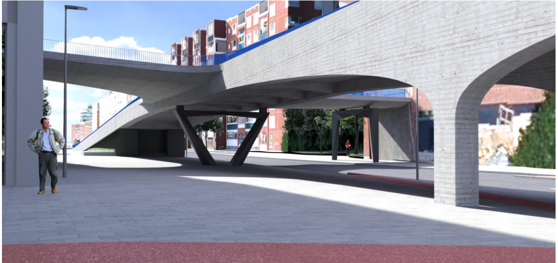
Kuva 34. Näkinsillan T1 tuki ja hulevesipumppaamon sisäänkäynti. (Lähde: https://www.kruunusillat.fi . Luettu 27.3.2023)
