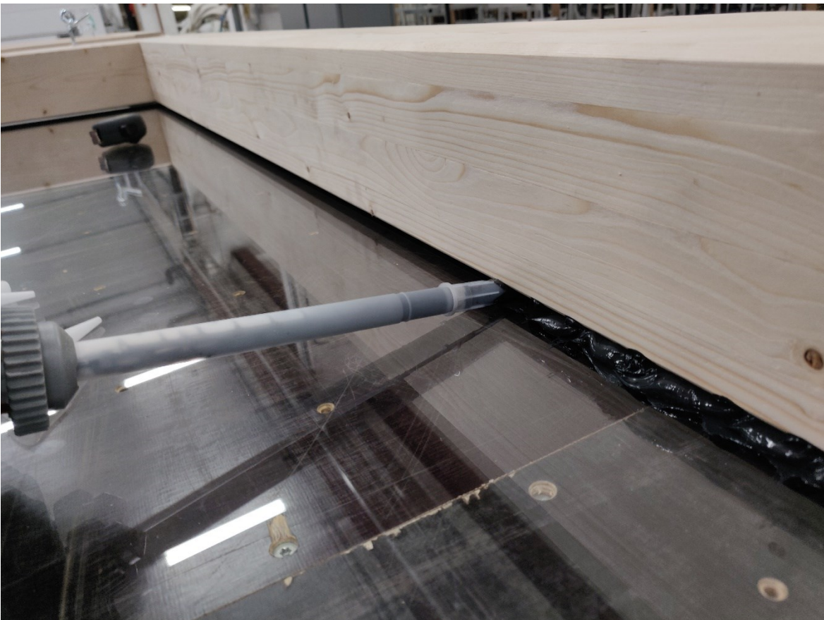
Kuva 12. Lasin liimaus kehärakenteeseen.
