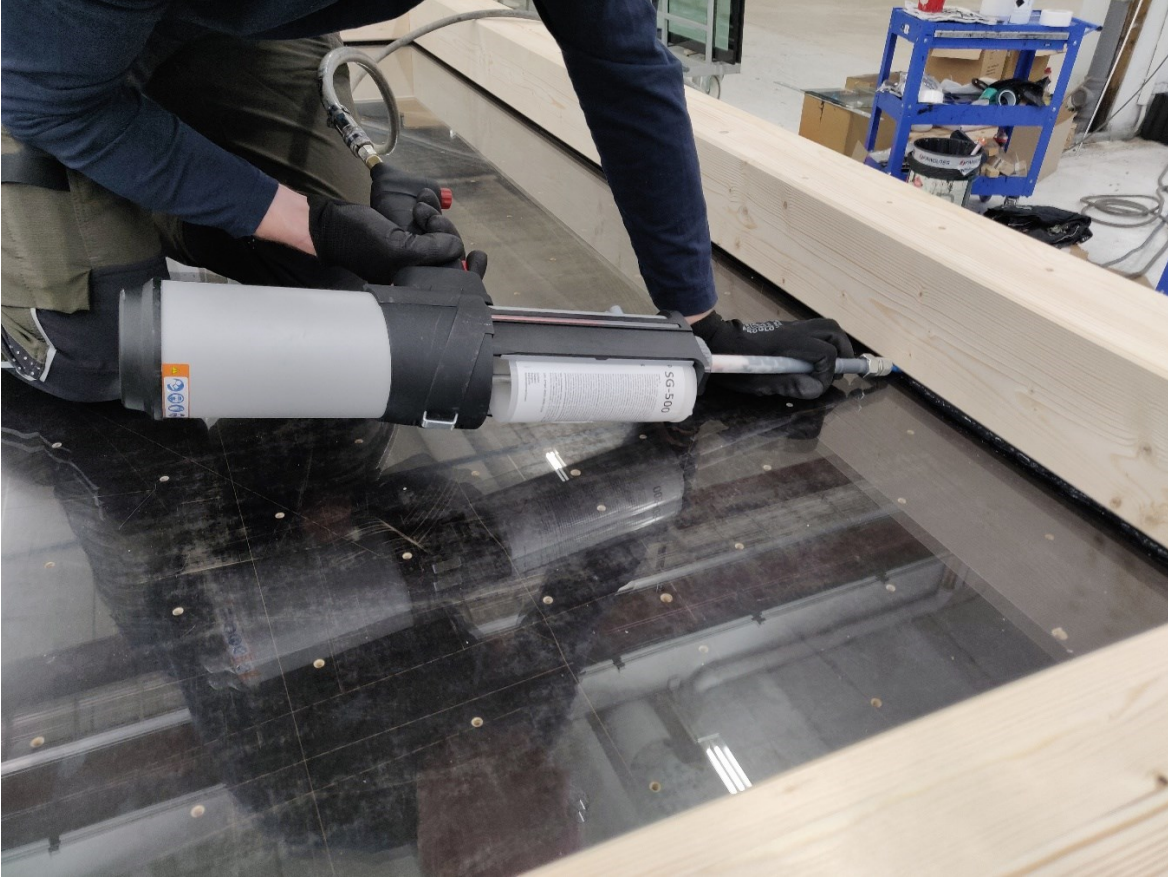
Kuva 11. Lasin liimaus kehärakenteeseen.
