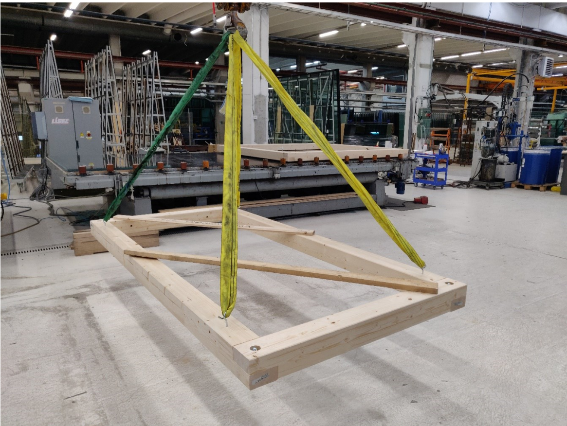
Kuva 9. Kehärakenne valmiina nostettavaksi lasin päälle.
