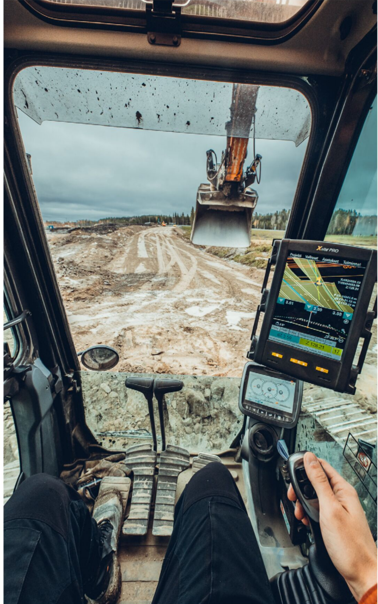
Inom maskinstyrning har man kommit långt. Av säkerhetsskäl lär det dock ta en lång tid innan maskinerna kan köras utan förare, trots att tekniken redan finns för att köra enligt givna modeller. Foto: Novatron Oy FOTO: NOVATRON OY
