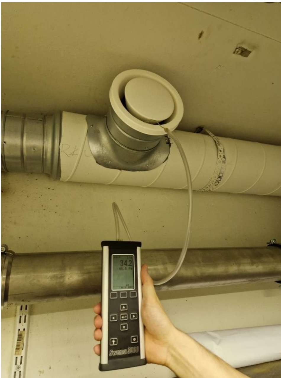
Kuva 11. Teknisen tilan ilmamäärän mittaaminen.
