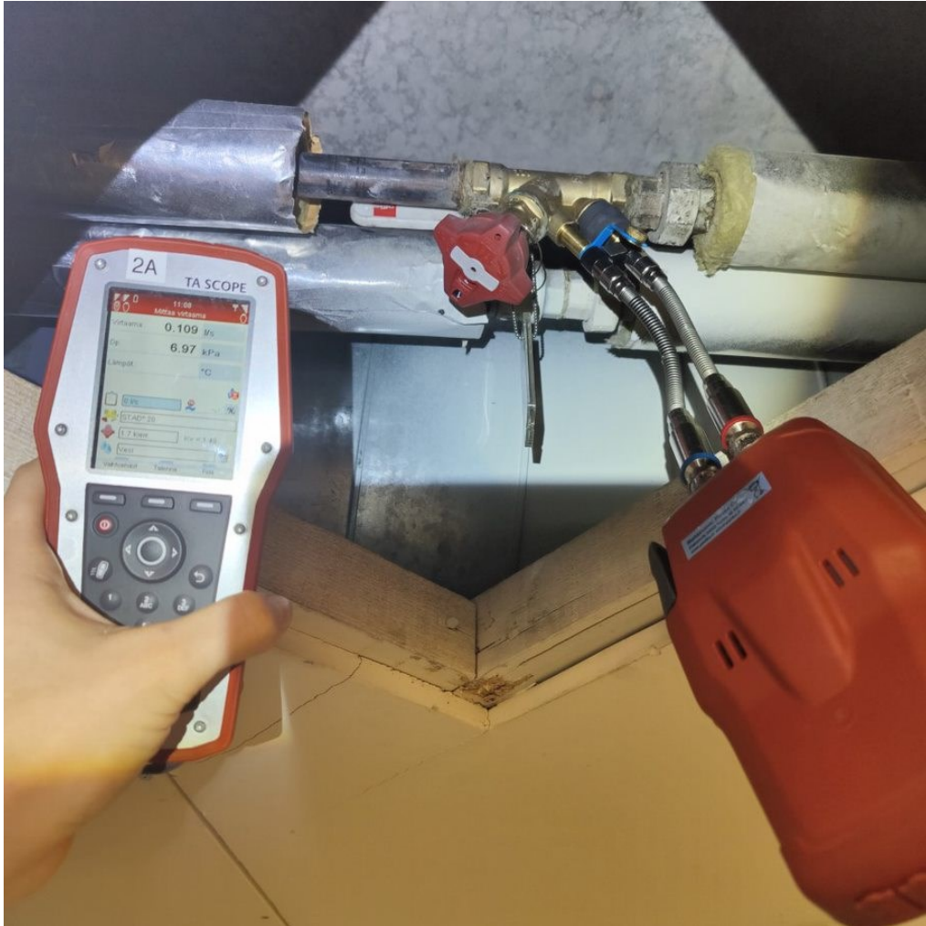
Kuva 10. Lämmityksen linjasäädön mittaus.
