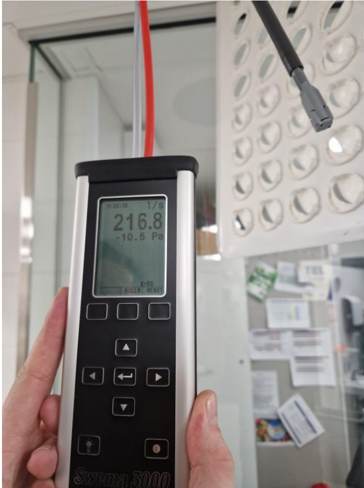
Kuva 13. Keittiön ilmamäärän mittaus.
