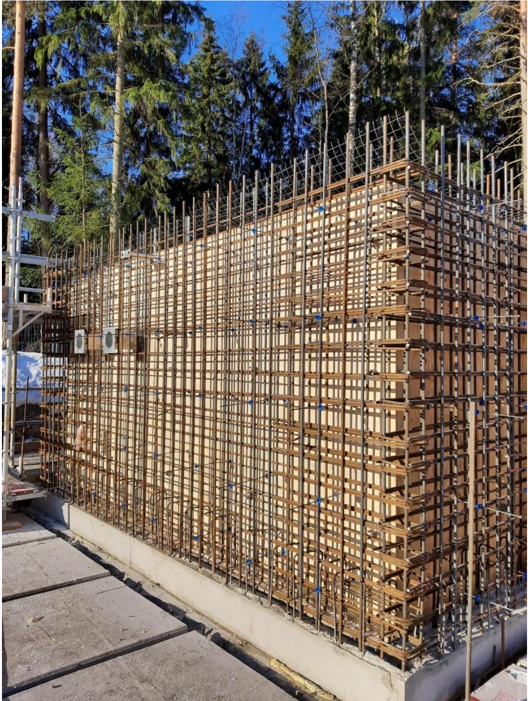
Kuva 7. Väestönsuojan raudoitus (Sitowise 2022)
