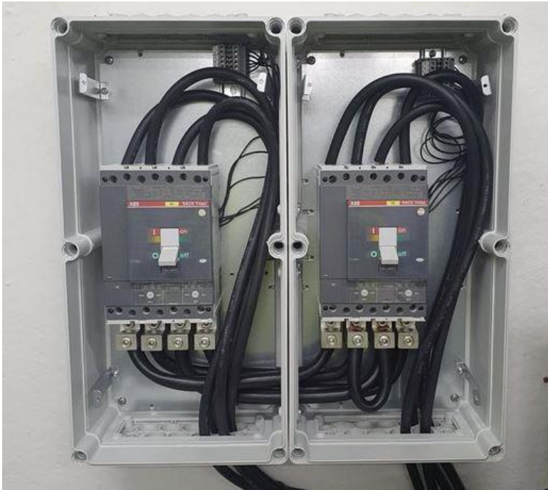
KUVA 27. ABB:n akustokatkaisijat
