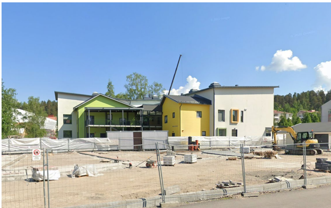
Kuva 1. Humpulan päiväkoti työmaavaiheessa, Lähde: Google Maps 2022.
