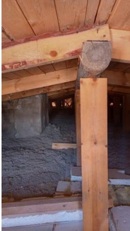
KUVA 23. Termex- selluvilla 100mm yläpohja asennettu helmikuu 2016.
