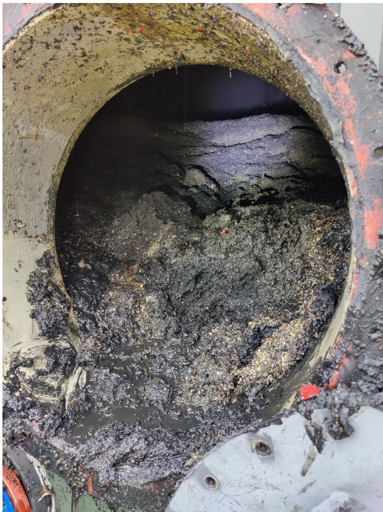
Kuva 10. Reaktorin sakkakertymä kuvattuna reaktorin kyljen miehistöluukusta (Harri Manu 2022, CC BY-SA)
