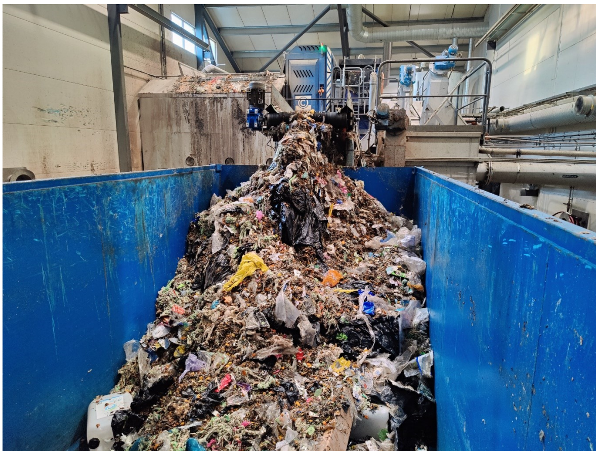
Kuva 36. Tigerin karkeaa hylkyä ja Huber-laitteen välppähylkyä hylkylavalla (Harri Manu 2022, CC BY-SA)
