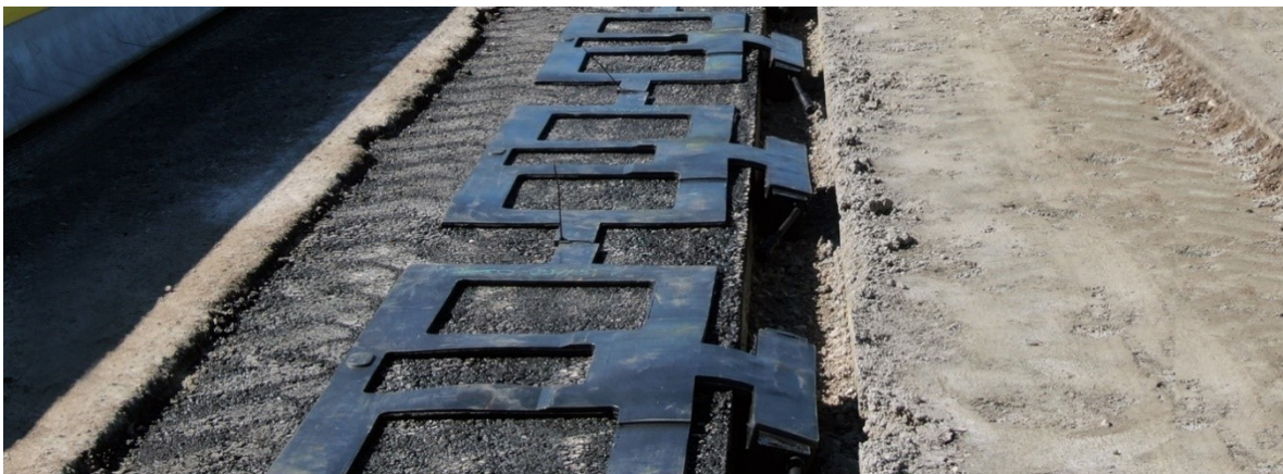
Kuva 16: Useita lähettämiä asennettuna tien alle (Smartroad Gotland, 2022b).
