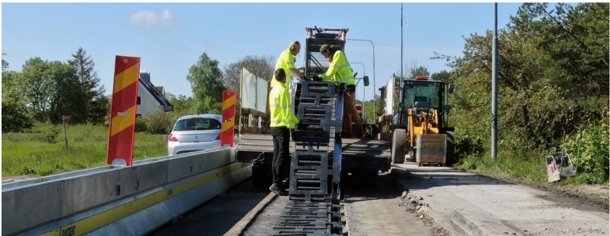
Kuva 19: Lähettimien puoliautomaattinen asennustapa (Smartroad Gotland, 2022b).
