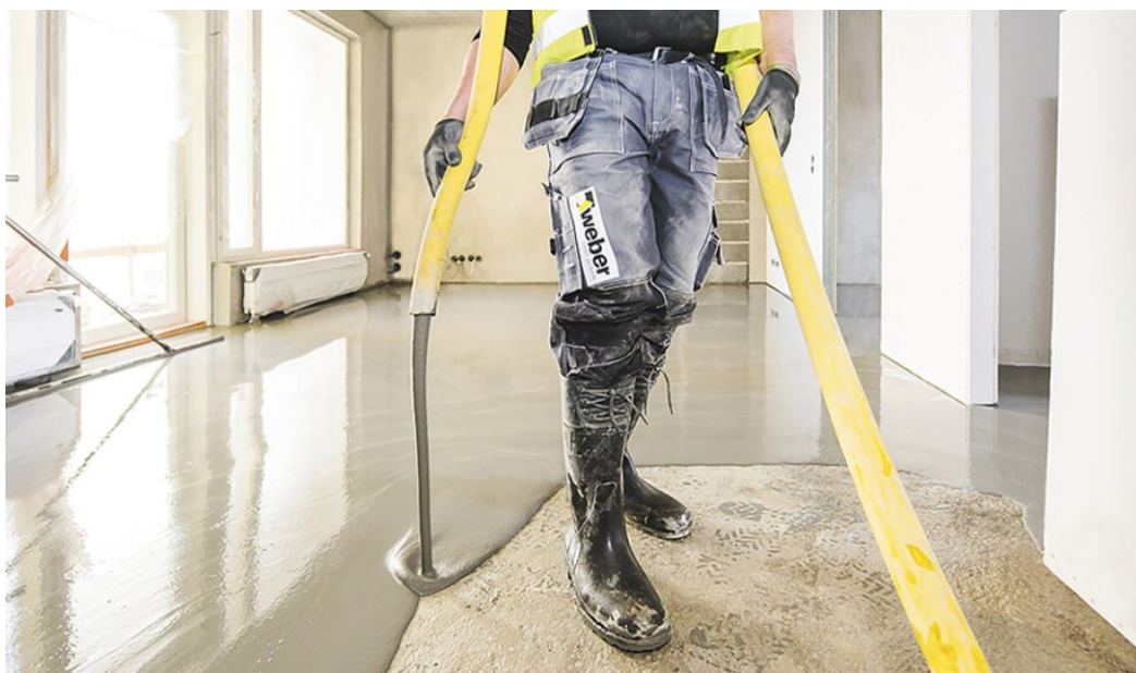
Kuva 7. Lattiapinnan tasoittamista lattiatasoiheen avulla.
