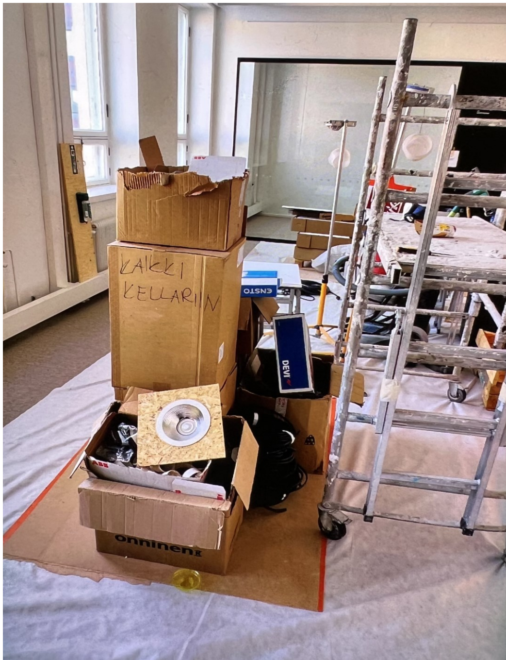
Kuva 5. Kerrokseen varastoitua kalustoa ja rakennustarvikkeita.
