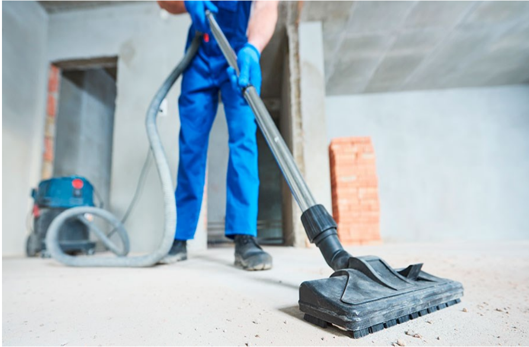
Kuva 2. Työntekijä imuroi pölyjä lattialta rakennuspölynimurin avulla.
