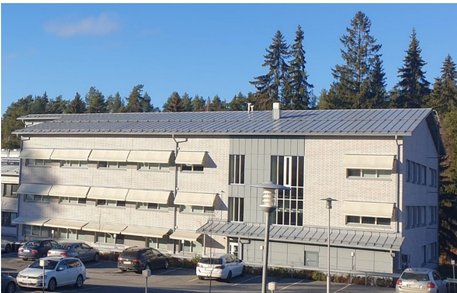
Kuvio 16. Kohdekiinteistön katon osa, jolle aurinkovoimala sijoittuu
