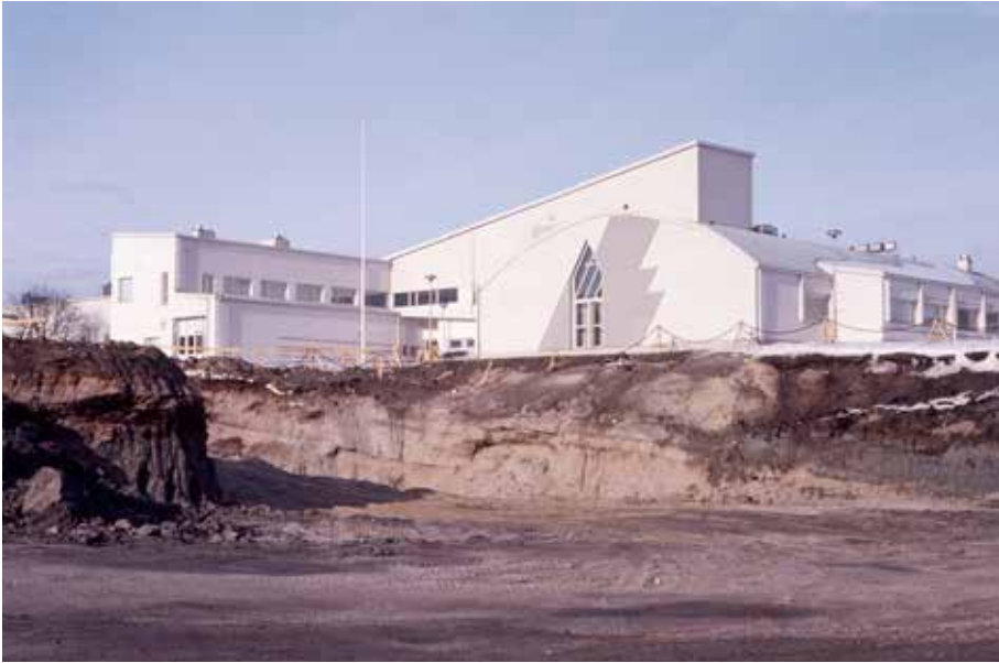
Kuva 12. Hipposhallin rakennustyömaan kuoppa, jonka reunasta erottuu paksu turve- ja savikerros. Taustalla vuonna 1989 valmistunut Jyväskylän yliopiston laboratoriorakennus. Kuvassa näkyvä lumihanki viittaa siihen, että kuva olisi otettu kevättalvella 1991. Kuvaaja: Taito Mörk, 1991. Kuva: Keskisuomen museo (K2167/1212).
