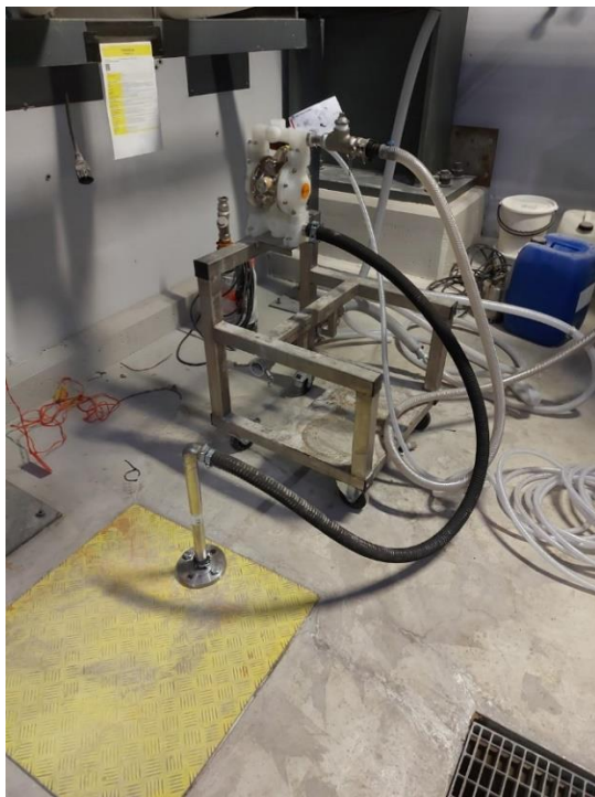
Kuva 5. Painelaitetoiminen kalvopumppu asennettuna jätevesikanaaliin
