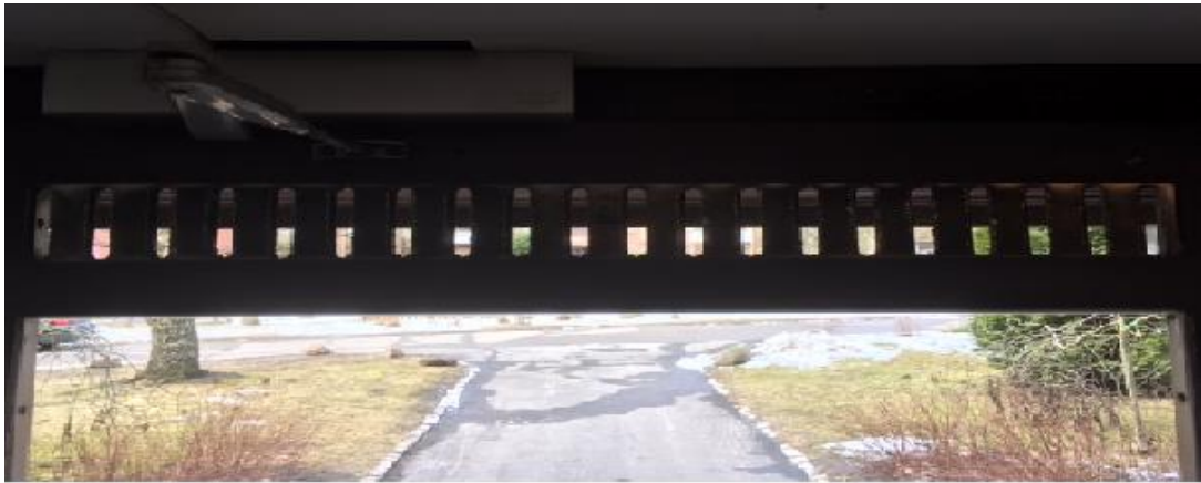
Kuva 6, esimerkki porraskäytävän korvausilmaventtiilistä.
