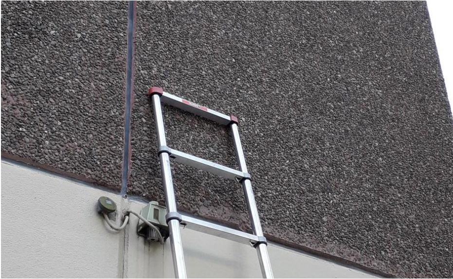
KUVA 1. Asuinkerrostalon betonielementtiseinä (kuva Leena Pekurinen)
