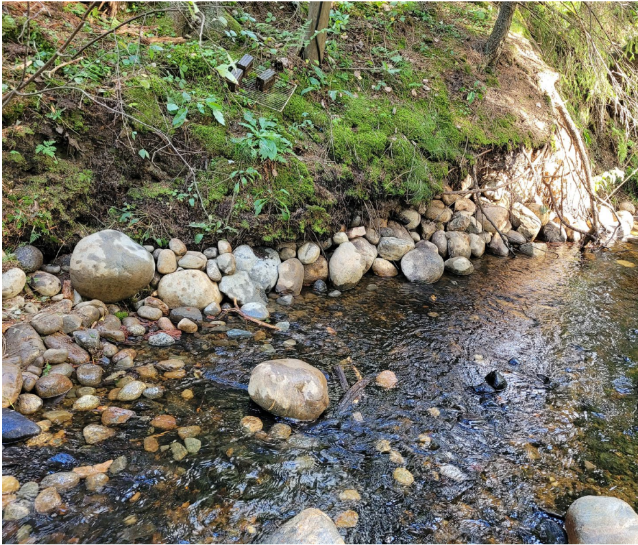
KUVA 4. Erosiosuojausta (kuva Juho Rajala).
