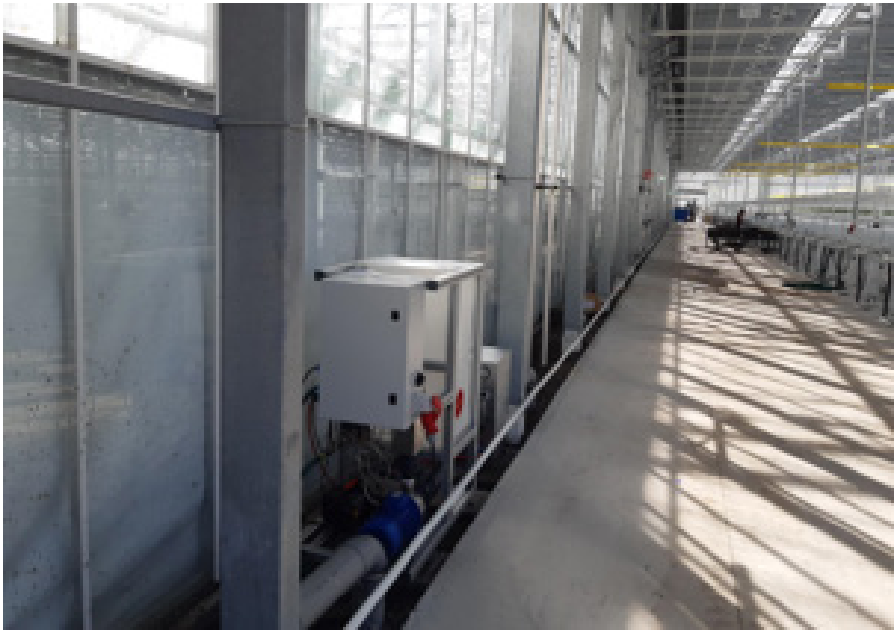
Kuva 3. Nanokuplien tuottamiseen kehitetty laitteisto asennettuna.
