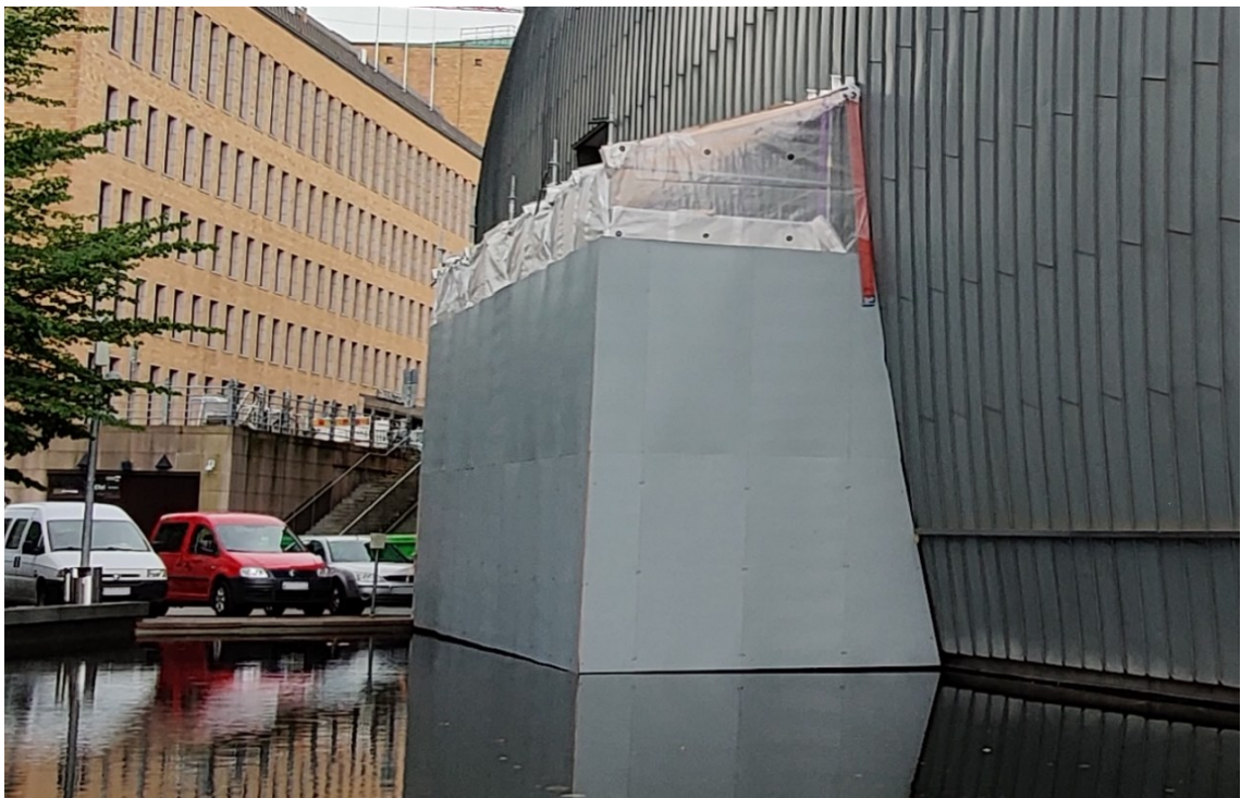
Kuva 16. Yleiskuva koerakenteen sääsuojasta.
