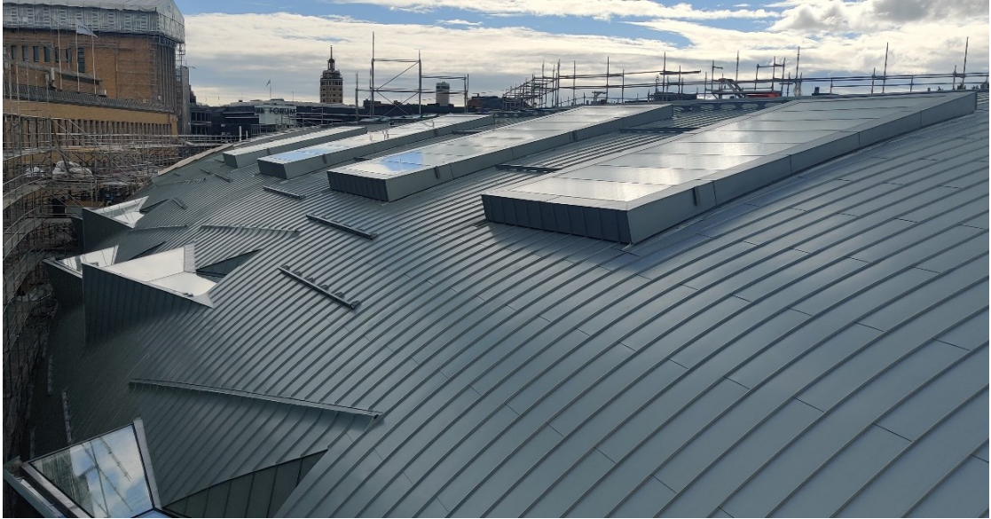
Kuva 3. Valokuva titaanisinkkikatosta 19.9.2022. Valokuvan keskellä patjaikkunoita ja vasemmassa reunassa rusetti-ikkunoita.
