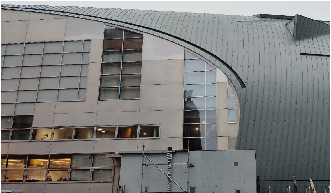
Kuva 9. Itäjulkisivun kaareva räystääslinja korjaamisen jälkeen. Valokuva otettu 9.11.2022. Räystääkourun rakennetta on muutettu ja kaaren linjakkuutta parannettu alkuperäisestä.
