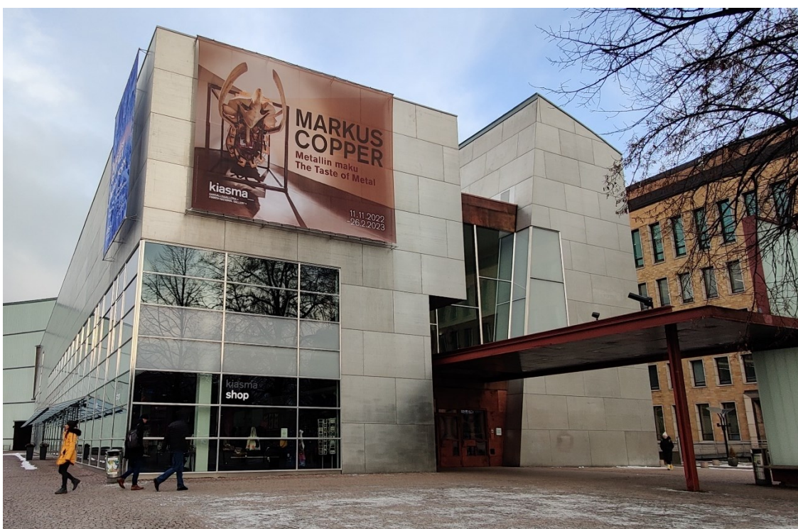
Kuva 7. Eteläjulkisivu korjauksen jälkeen. Valokuva otettu 2.12.2022.
