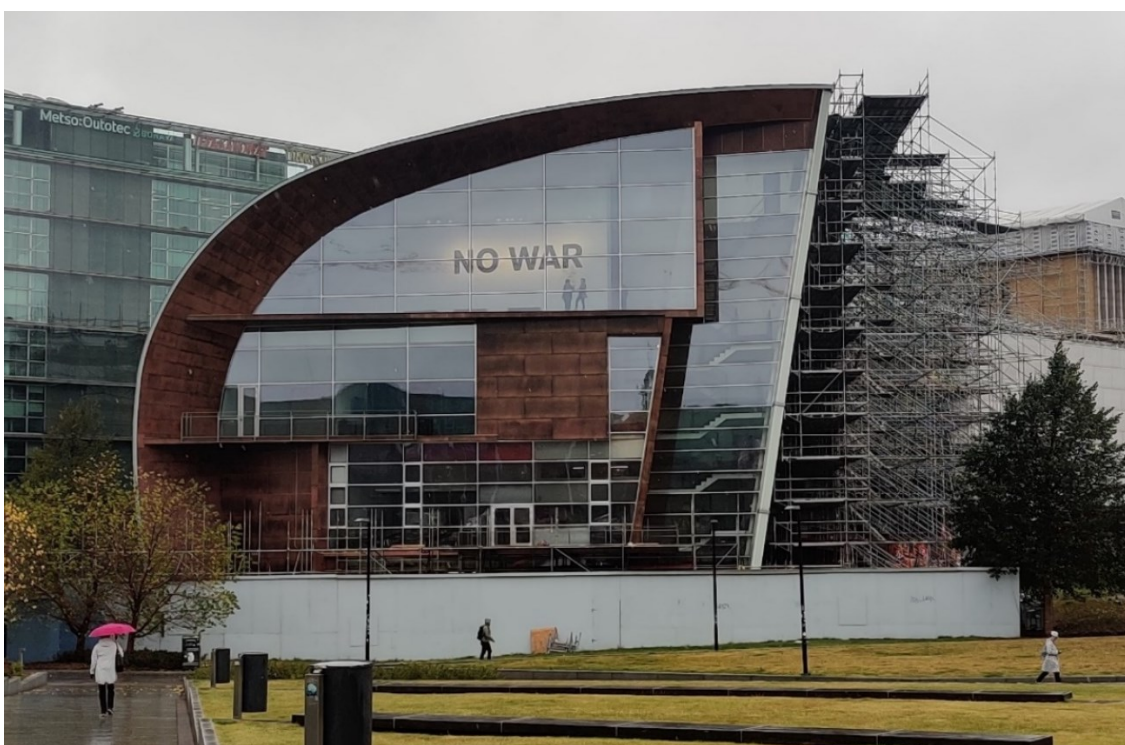
Kuva 11. Pohjoisjulkisivu korjauksen jälkeen. Valokuva otettu 29.9.2022.
