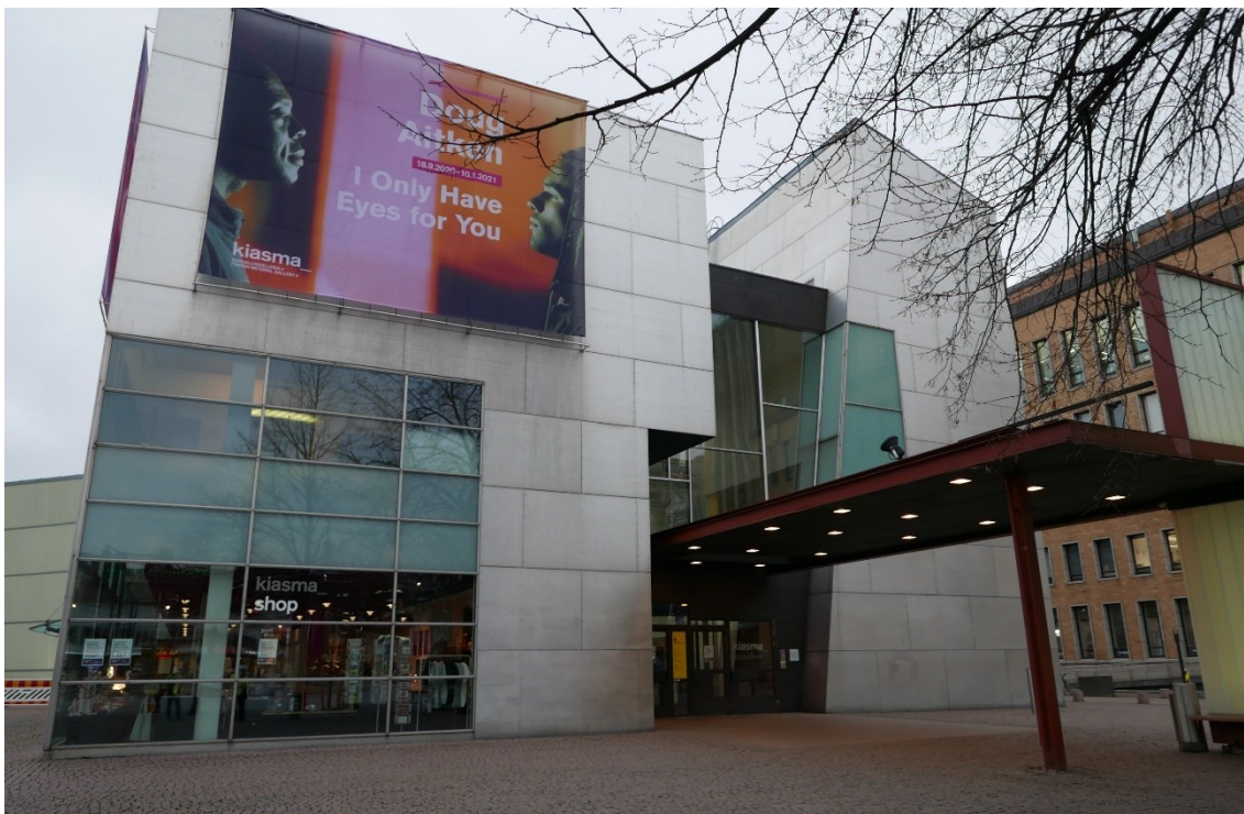
Kuva 6. Eteläjulkisivu joulukuussa 2020. (Valtonen J. 2020a).
