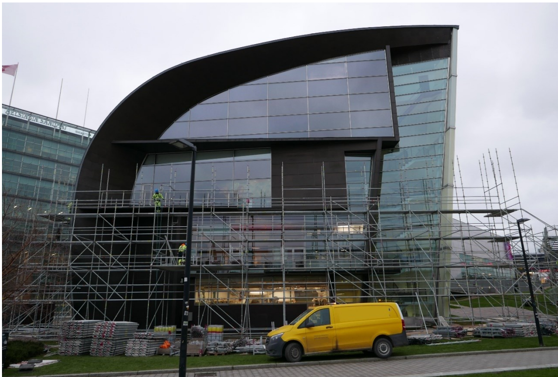
Kuva 10. Pohjoisjulkisivun ennen korjausta. (Valtonen J. 2020b)
