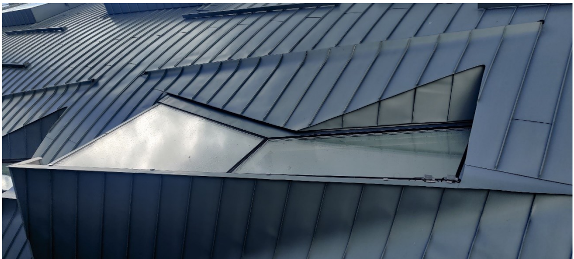
Kuva 26. Titaanisinkkikaton ruseetti-ikkuna valmiina. Valokuva otettu 19.9.2022.
