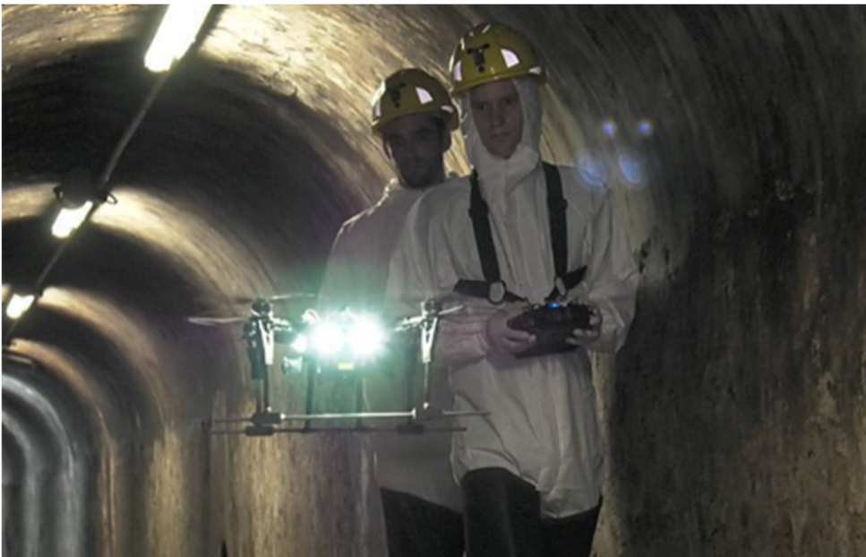
KUVA 8. Drone-lennokin lennättämistä viemäritunnelissa Barcelonassa 2018 (10)
