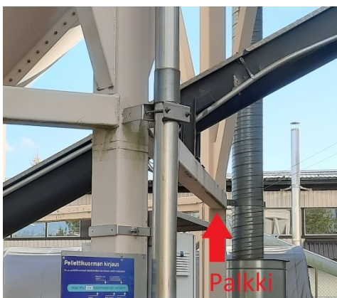
Kuva 15. Pellettsiilon tukipalkki.
