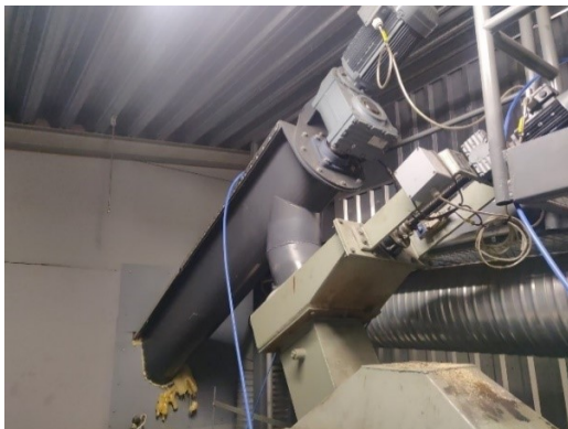
Kuva 3. Varastokuljettimen ja välisiilon yhtymäkohta.
