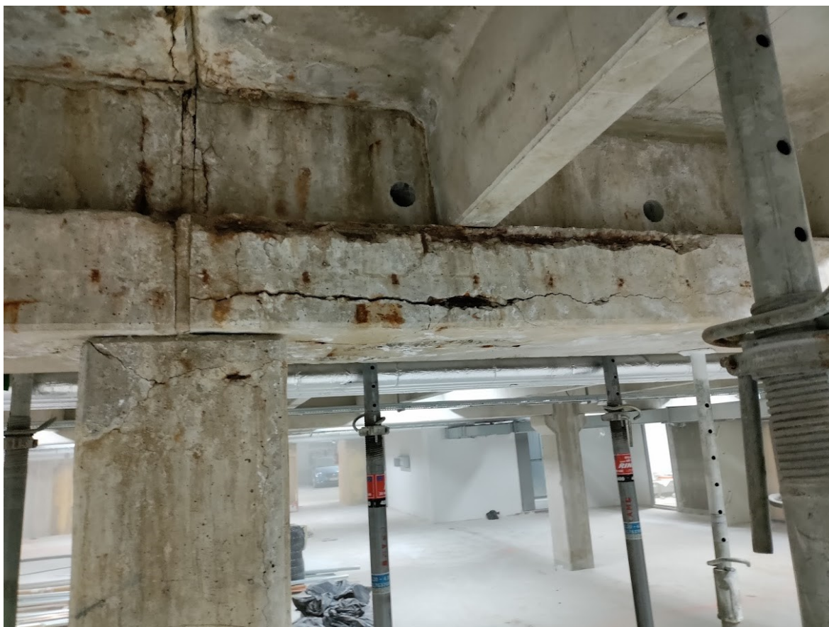
Figur 13. Bilden visar hålplaceringen i balken.
