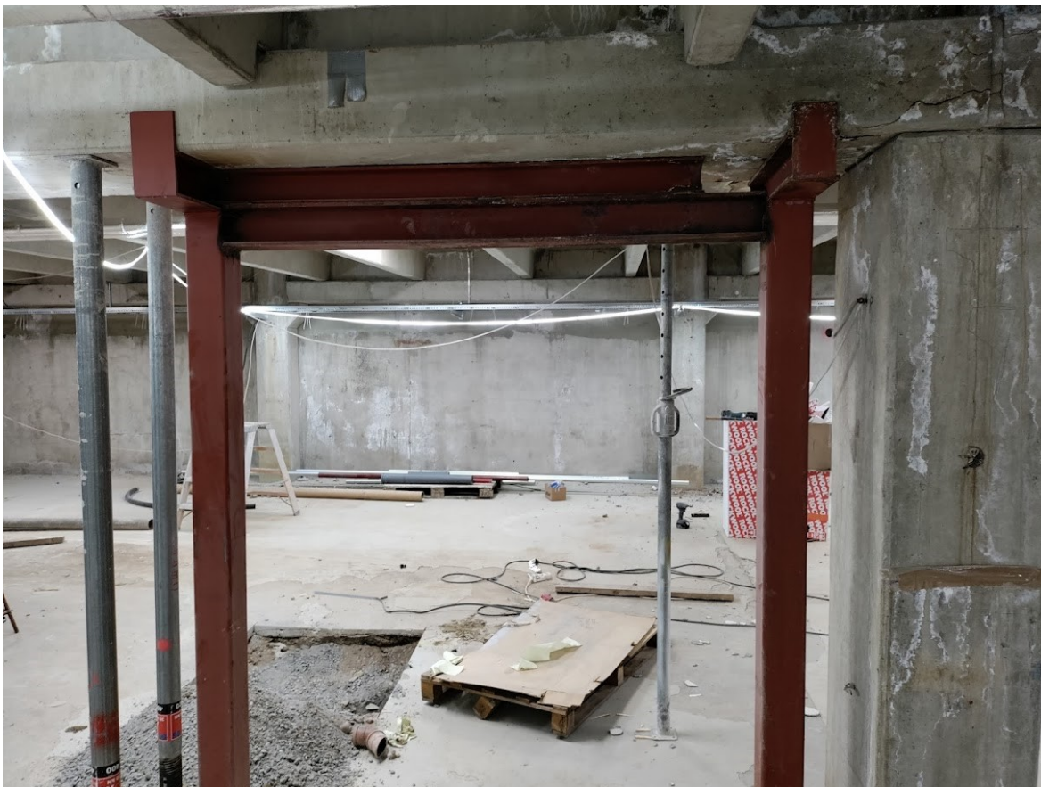
Figur 8. Bild på hur balken blivit stödd efter att den försvagats.
