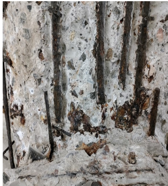
Figur 17. Dragarmeringen kapad före stödet.
