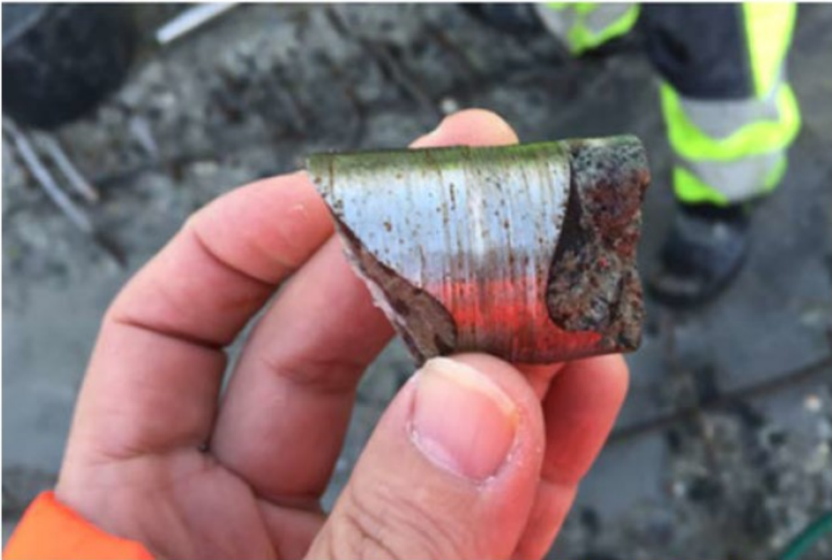
Figur 51 Kappat grov armering ved kjerneboring på Ladedalen bru. Perica Benic
