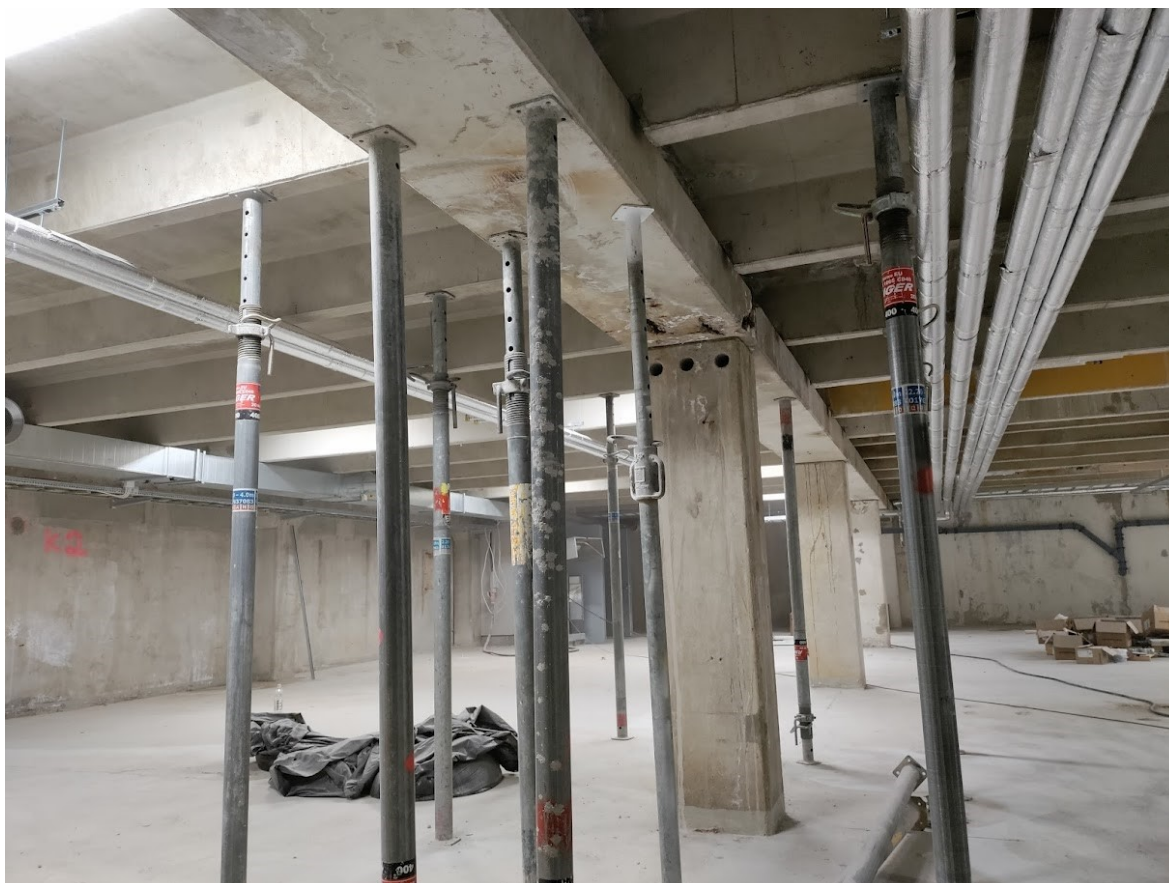
Figur 11. På bilden ser man hur bjälklaget stöttades.
