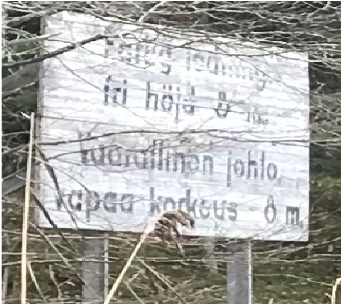
Kuva 17. Kenttähavainto kävelyretkeltä. Ränsistynyt, nykysäädösten vastainen, osittain kasviston peittämä varoituskylltti Raaseporissa Jomalvikin kanavan ylittävästä sähköjohdosta. (Nyholm 2022).
