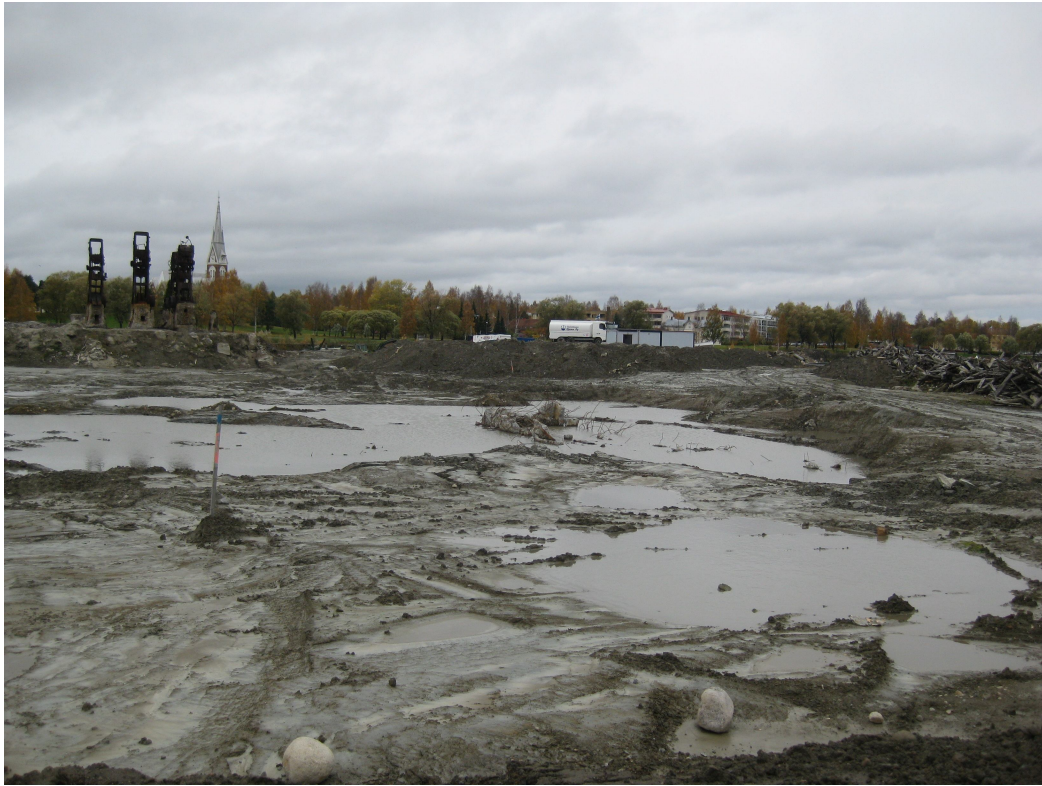
Kuva 6. Penttilän saha-alue pilaantuneen maa-aineksen kaivamisen jälkeen /8/.
