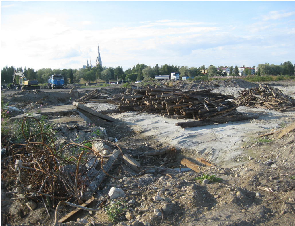
Kuva 5. Penttilän saha-alue kunnostustyön alussa /8/.
