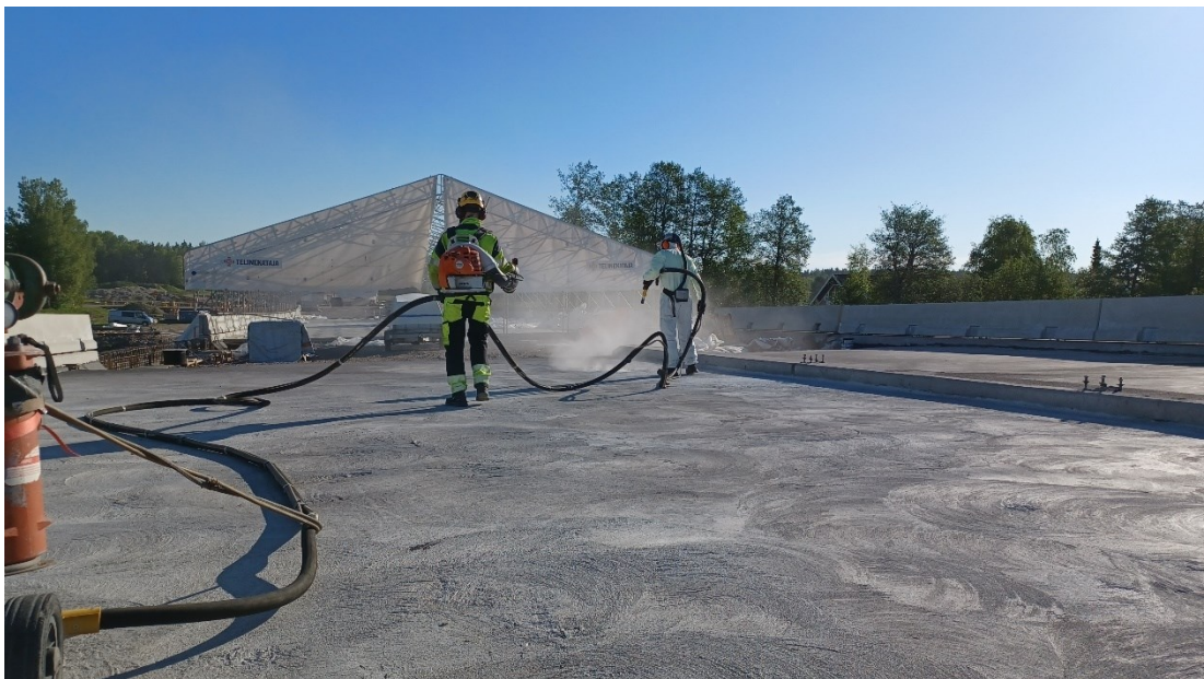
Kuva 13. Sillan suojabetonikerroksen kuonapuhallus (Männistö)
