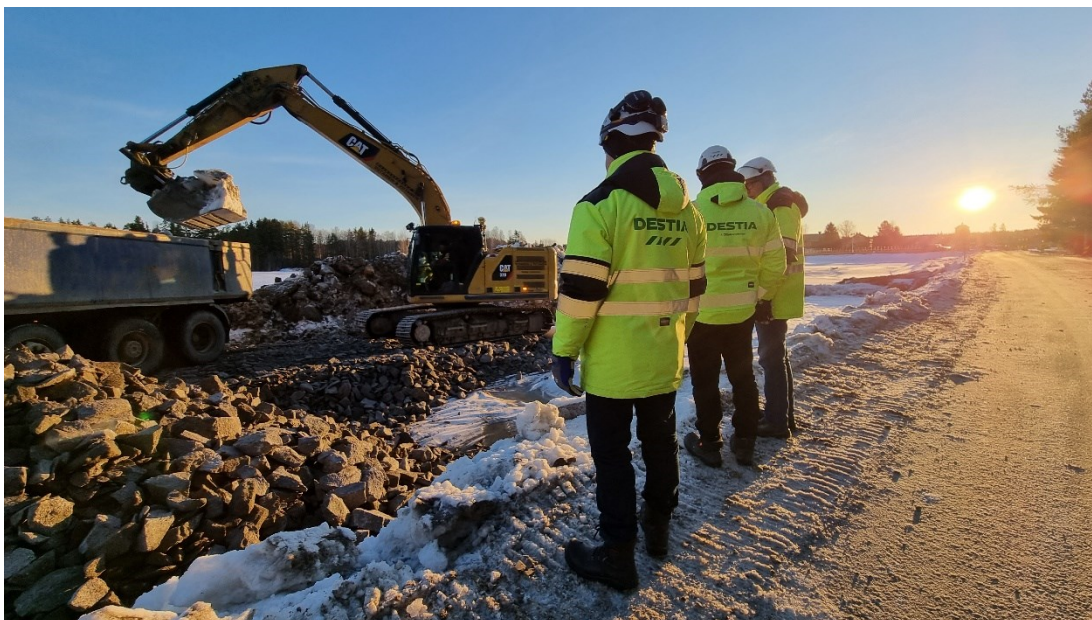
Kuva 2. Työnjohto työmaalla (Männistö)
