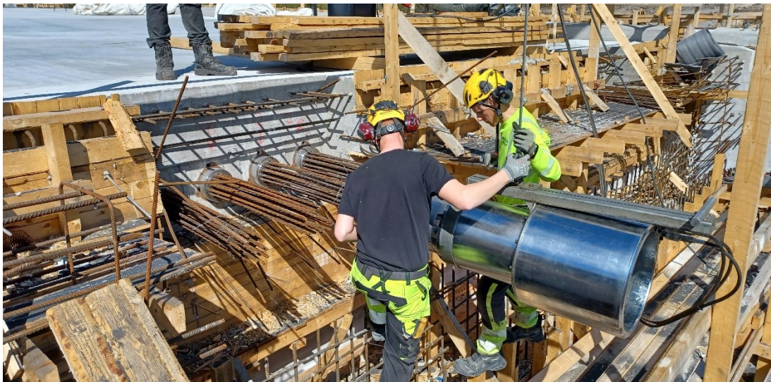
Kuva 16. Sillan jännitystyö (Männistö)
