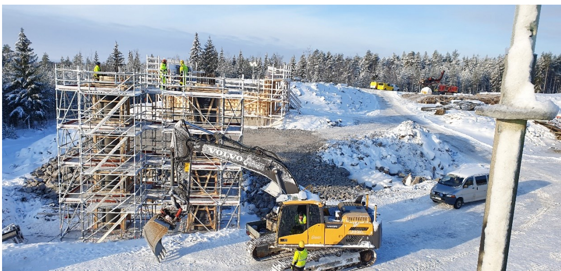
Kuva 17. Sillan välitukien rakennustelineet (Männistö)
