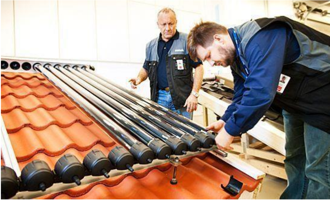
KUVA 5. Tyhjiöputkikeräimiä asennetaan katolla olevaan kehikkoon (5)
