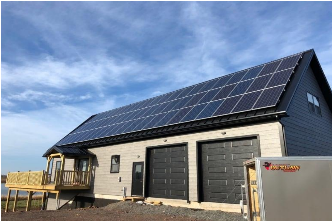
KUVA 2. Tyypillinen katolle sijoitettava kennojen sarjakytkentä (40)
