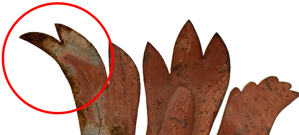
Kuva 37. Lohikäärmeen hännän yläosan ruostevauriota (Helander 2022).
