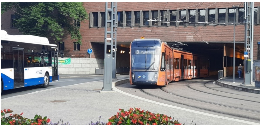
Kuva 2. Itsenäisyydenkadun alikulkusilta, Tampere (Salo 2022)
