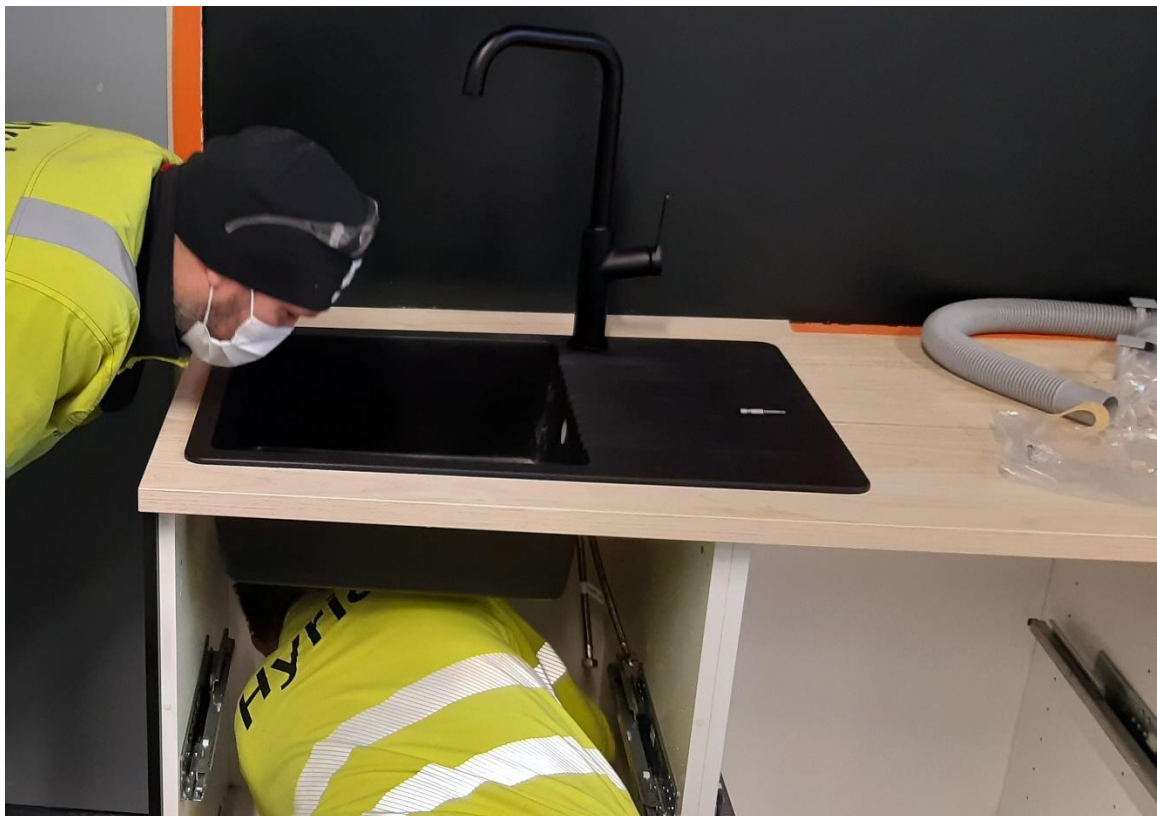
KUVA 79. Putkien asennus ja liitännät (Huovinen 2022)
