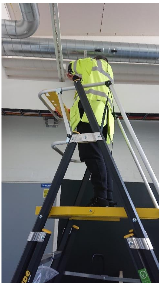
KUVA 82. Sähkötöiden viimeistely ja valaisimien asentaminen (Huovinen 2022).
