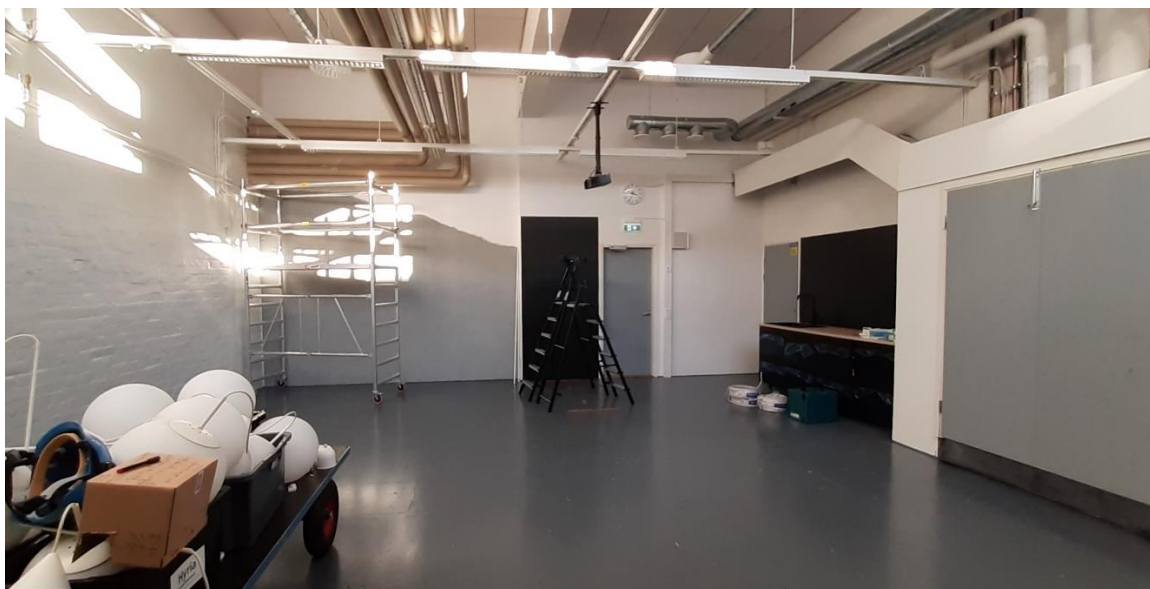
KUVA 81. Uudet sähkökiskot ja valaisinpistorasiat asennettu (Huovinen 2022)
