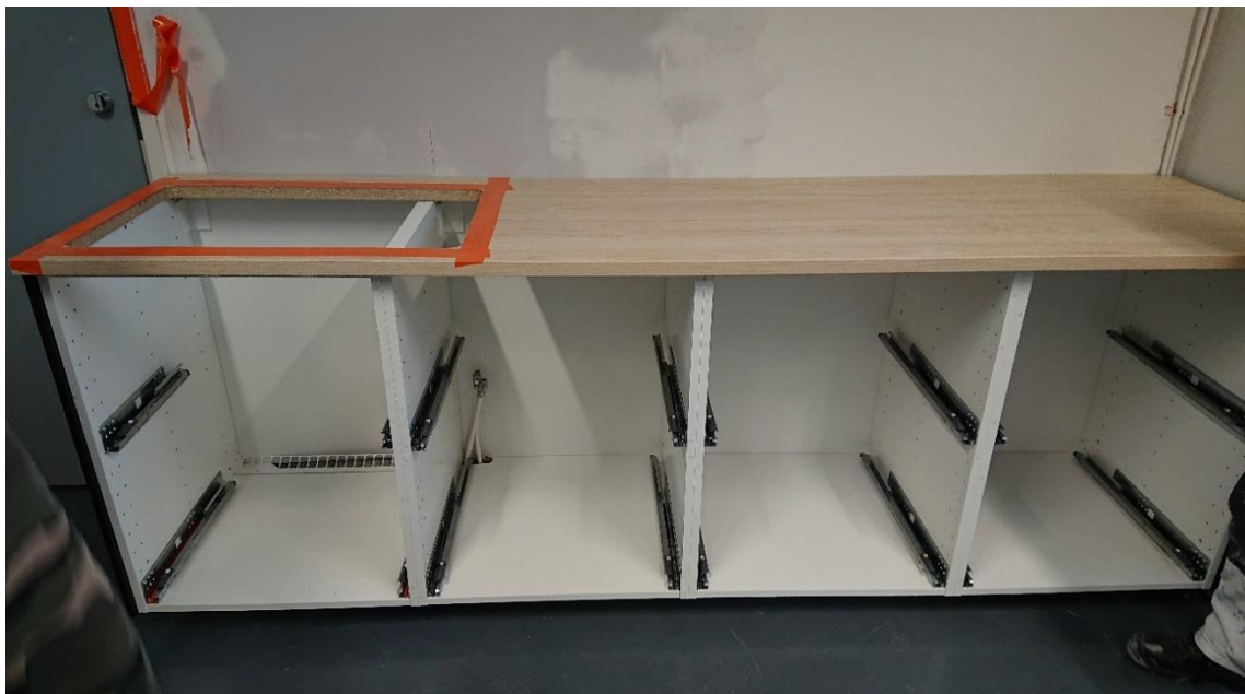
KUVA 77. Keittiötason kiinnitys runkoon (Huovinen 2022)
