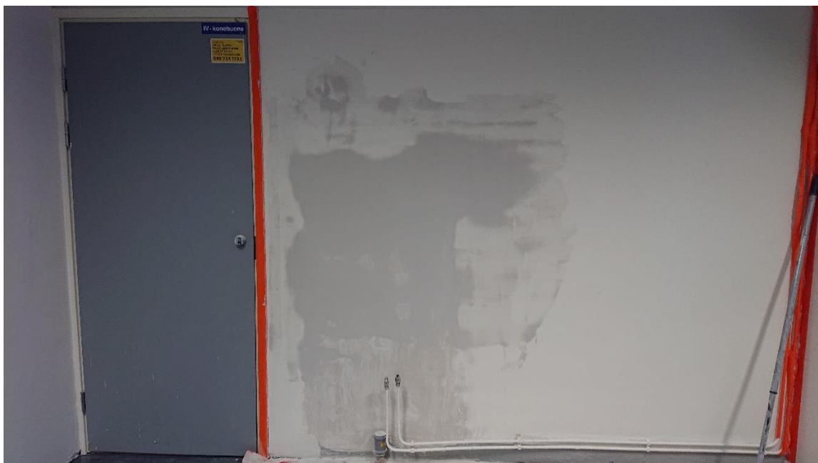
KUVA 69. Seinän tasoitustyöt (Huovinen 2022)
