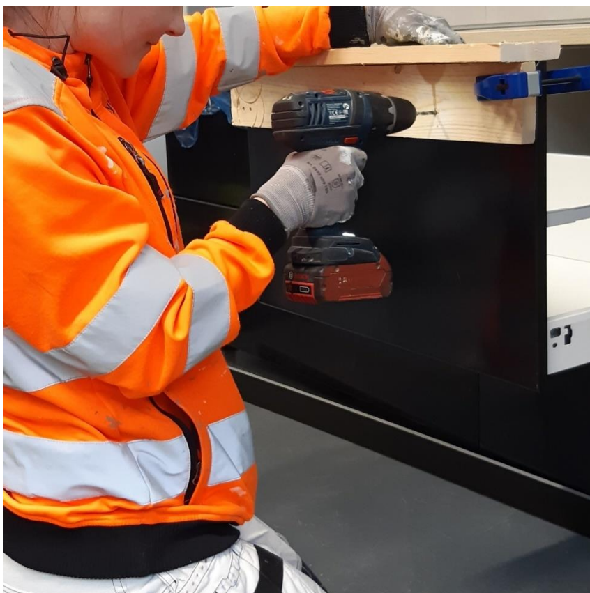
KUVA 78. Vetimien asentaminen (Huovinen 2022)
