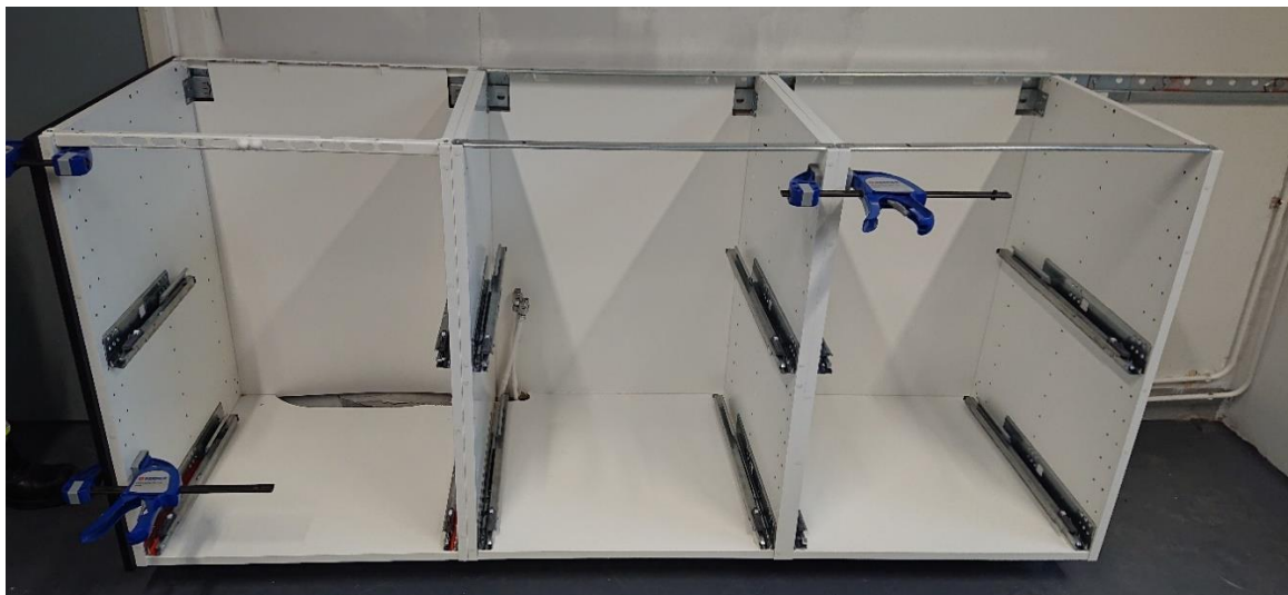
KUVA 75. Kaapiston runkojen asentaminen yhteen (Huovinen 2022)
