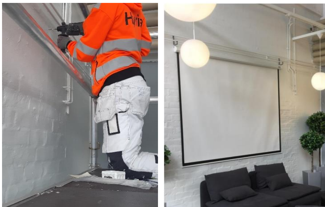
KUVA 90. Näissä kahdessa kuvassa kuvataan valkokankaan asennus ja lopputulos (Huovinen 2022). Sisustusalanopiskelija stailasi tilan suunnitelmien mukaisesti. Huopamatot asennettiin lattialle sekä kalustettiin ja stailattiin tila valmiiksi. Ilmakielkopeli kannettiin talon aulasta ja odotettiin biljardipöydän tuloa. Opiskelijoiden onneksi, biljardipöytä ehti paikalle juuri ennen avajaisia.
