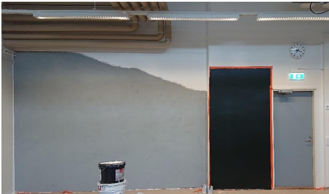
KUVA 67. Seinien pintakäsittelyä (Huovinen 2022)
