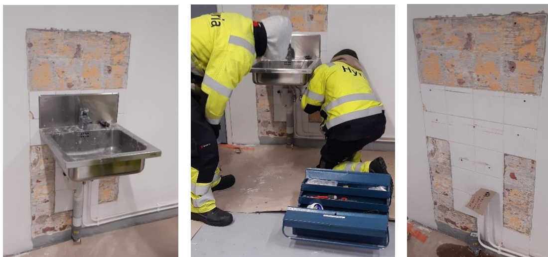
KUVA 68. Näissä kuvissa on laattojen irrotus- ja putkityövaiheet (Huovinen 2022)
