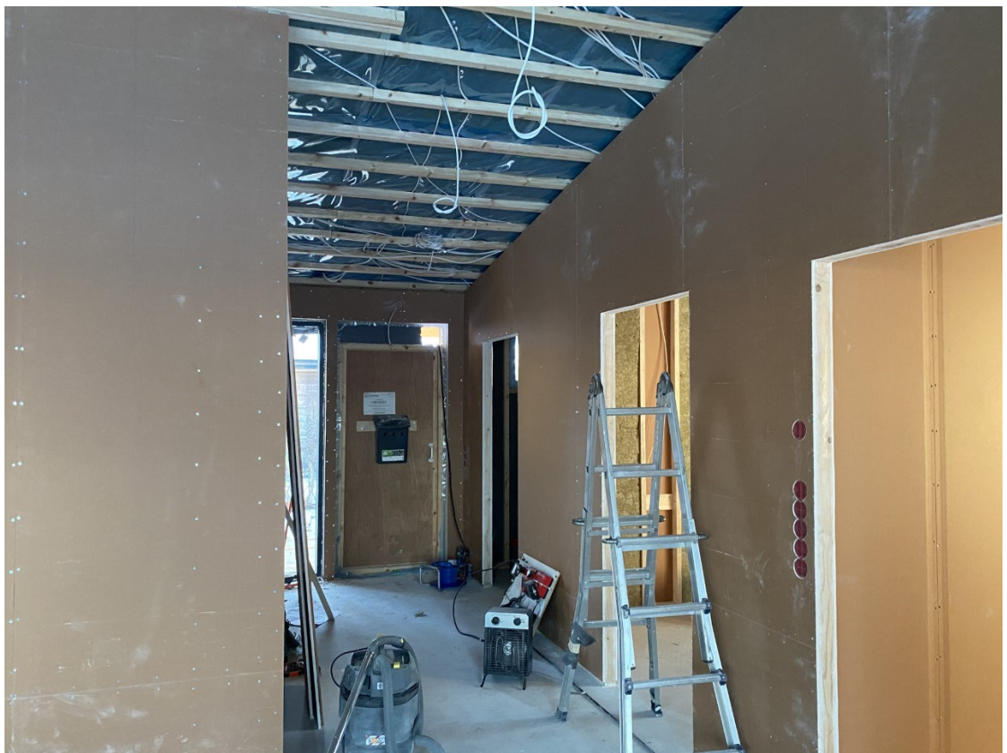
Kuva 11. Johdotus, yleiskuva omakotitalotyömaalta
