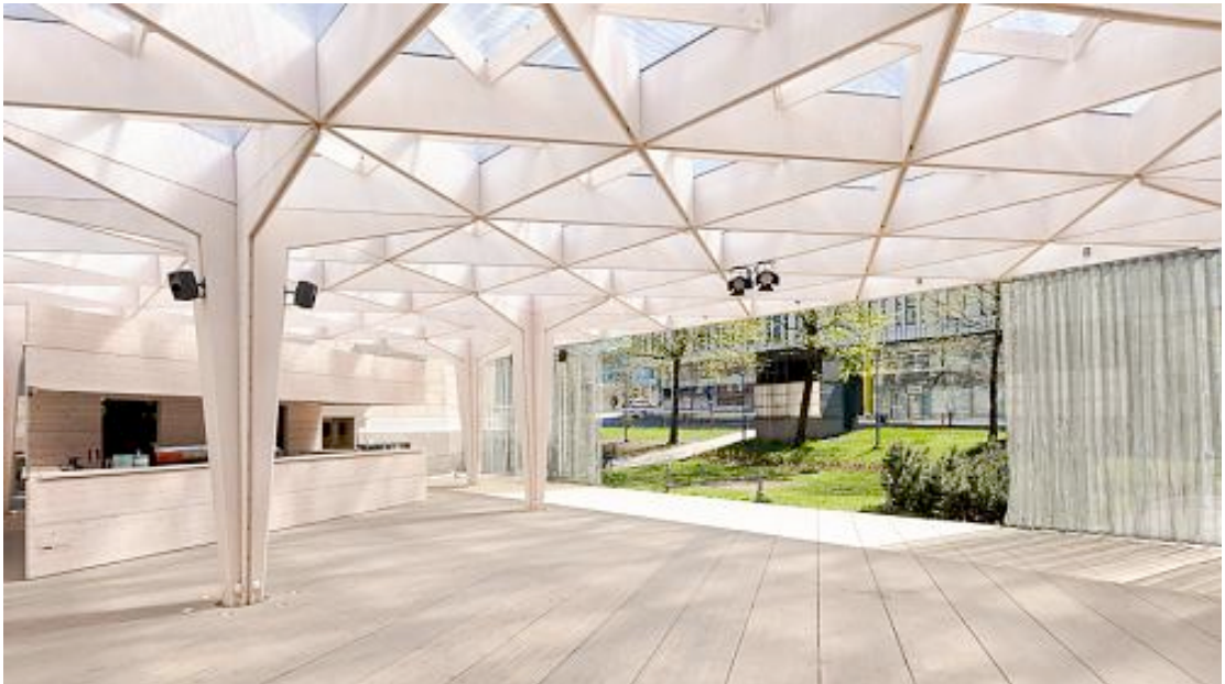
Kuva 23. WDC- paviljongin palosuojapetsatut puurakenteet Helsingissä (Kuva: ©Puuinfo 2014).
