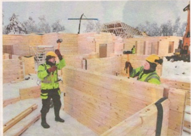
Timo Malinen (vas.) ja Antero Eskelinen asentavat vaarnatappeja päiväkodin hirsin Pudasjärvellä.
